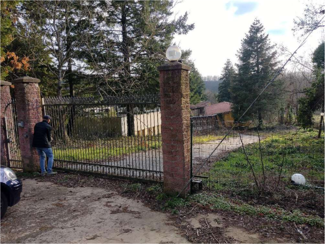
Figura 16. Lotto 1. Ingresso principale.
