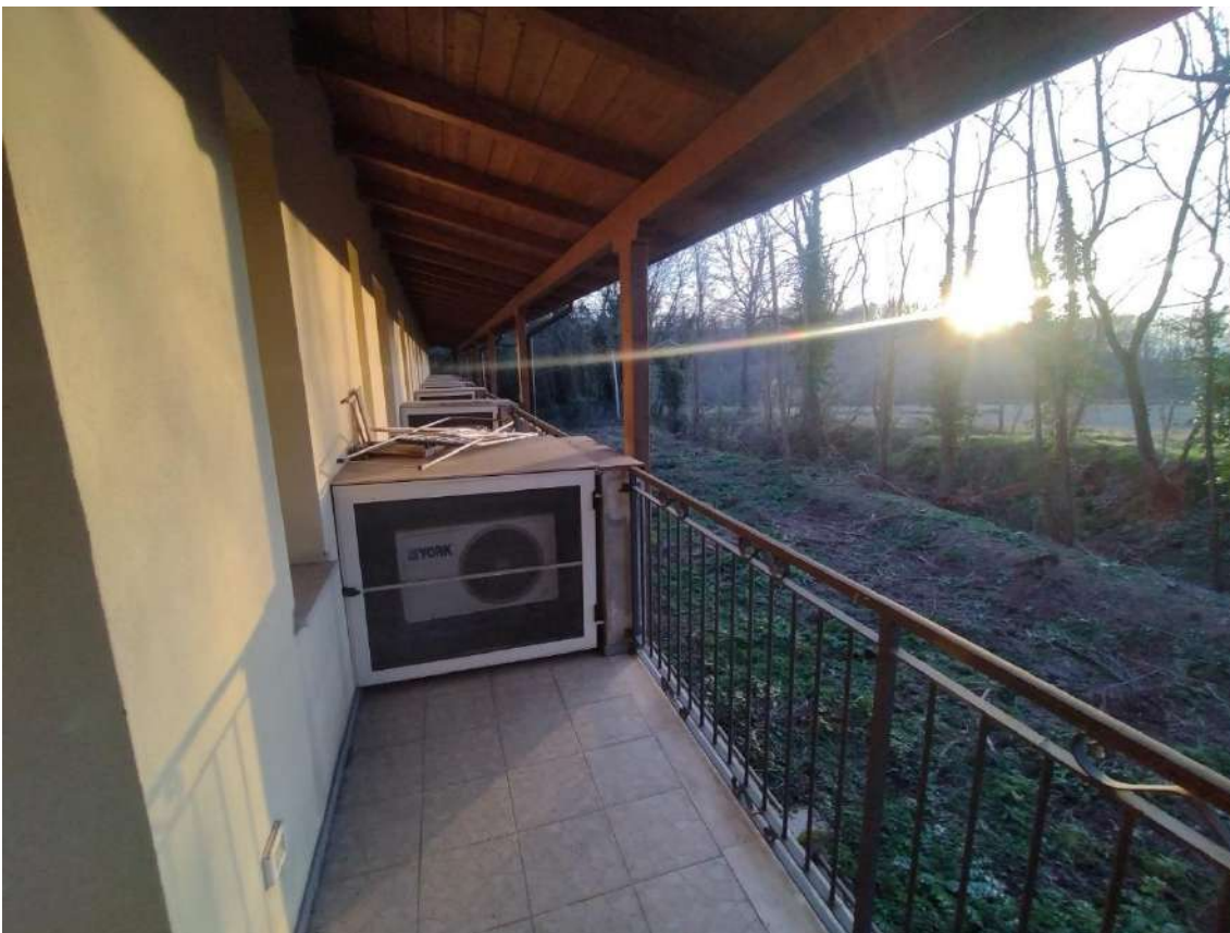
Figura 41. Lotto 1. Camera tipo, balcone e condizionatore.
