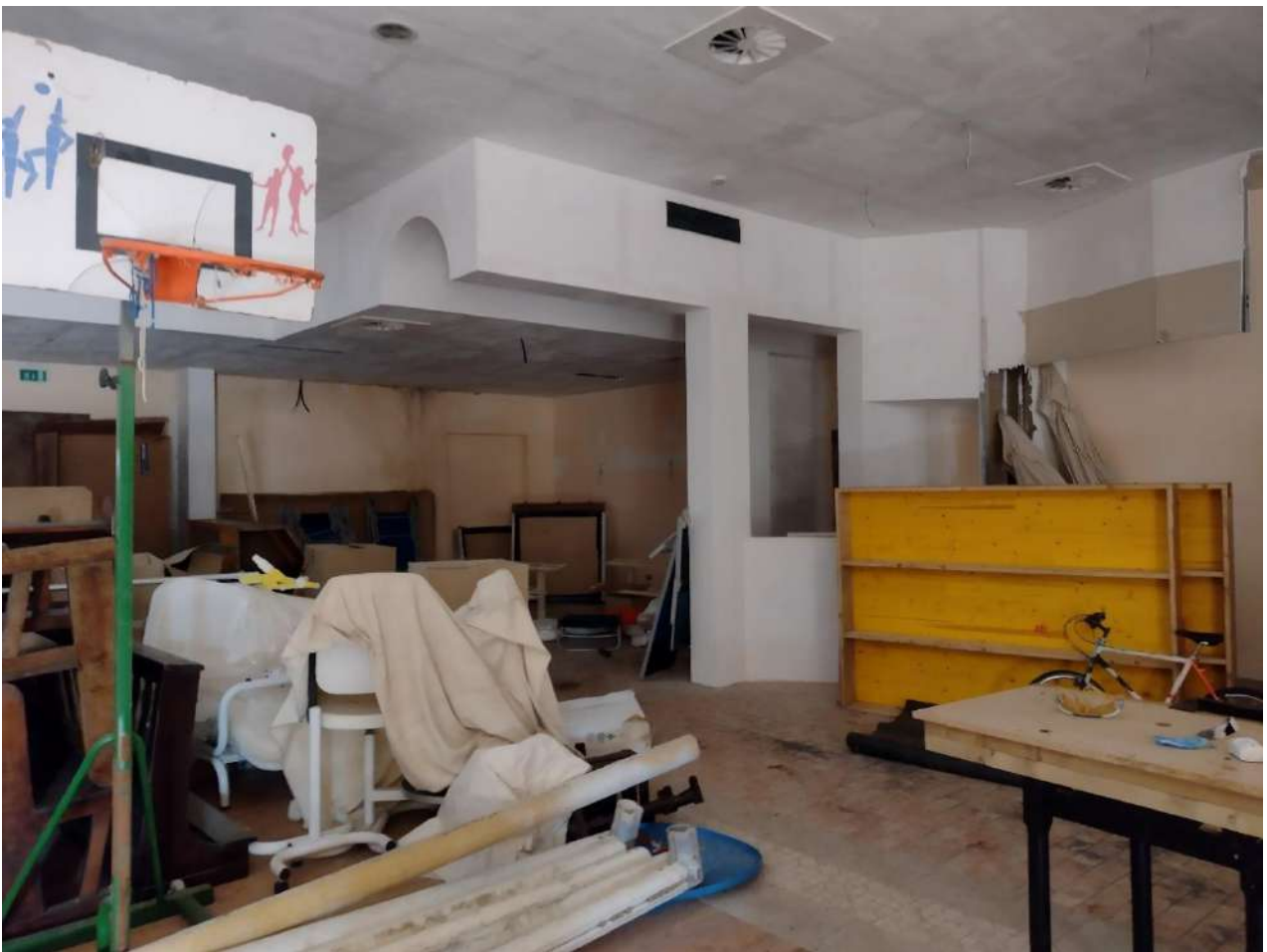
Figura 49. Lotto 2. Sala principale.
