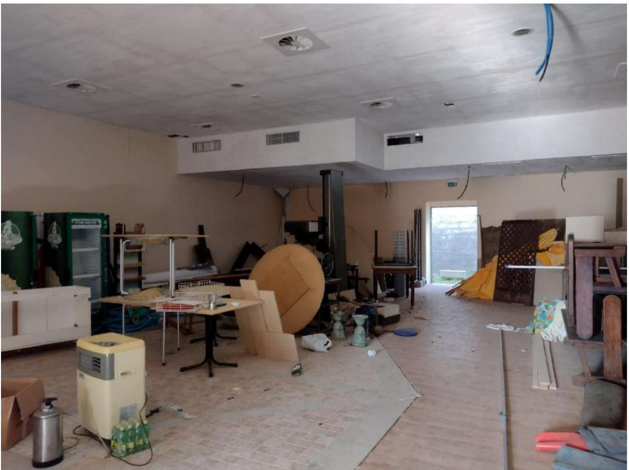
Figura 48. Lotto 2. Sala principale.
