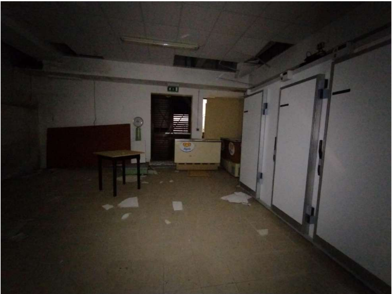
Figura 34. Lotto 1. Magazzini con celle frigo.
