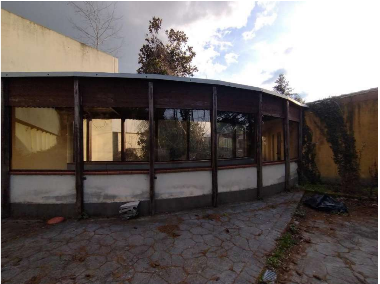
Figura 38. Lotto 1. Collegamento fra i due immobili.
