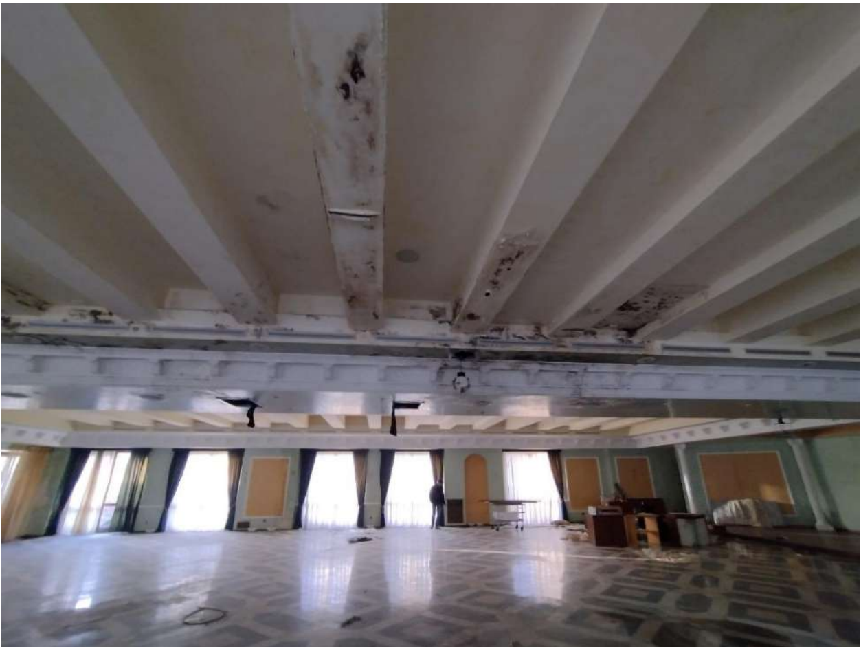
Figura 27. Lotto 1. Sala polifunzionale, particolare copertura.
