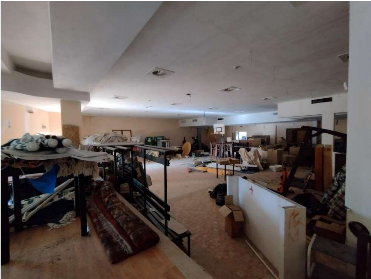
Figura 51. Lotto 2. Sala principale.
