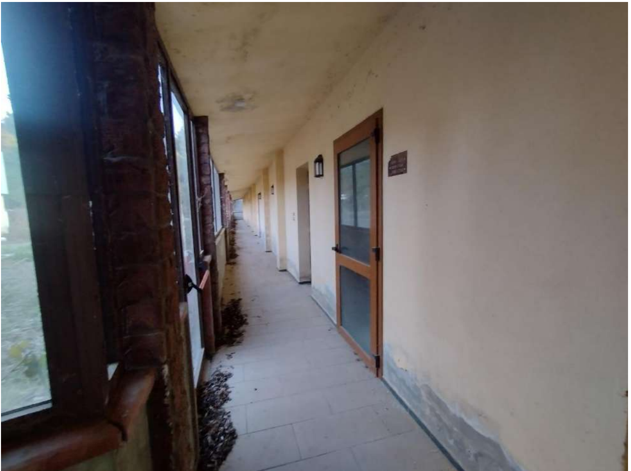
Figura 39. Lotto 1. Passerella di accesso alle camere.
