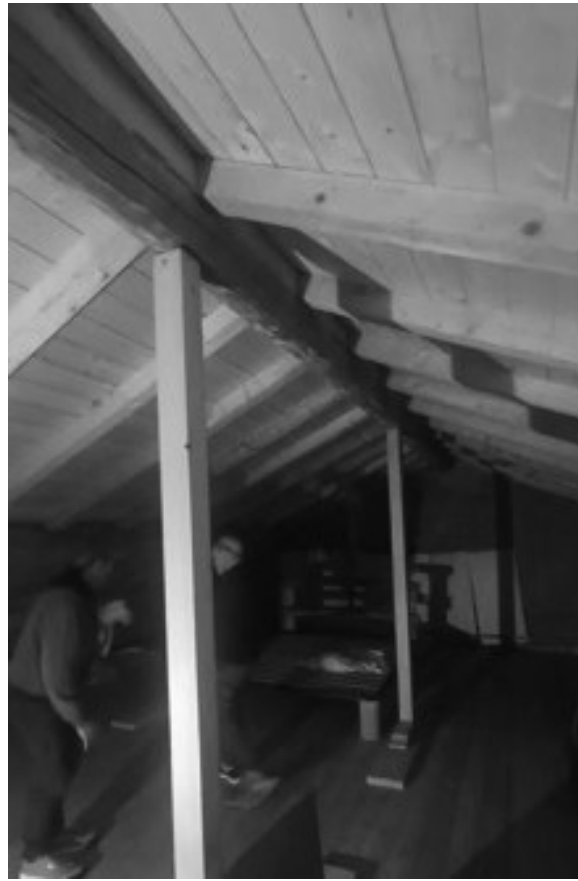
immagine 11: copertura lignea e relativi montanti
