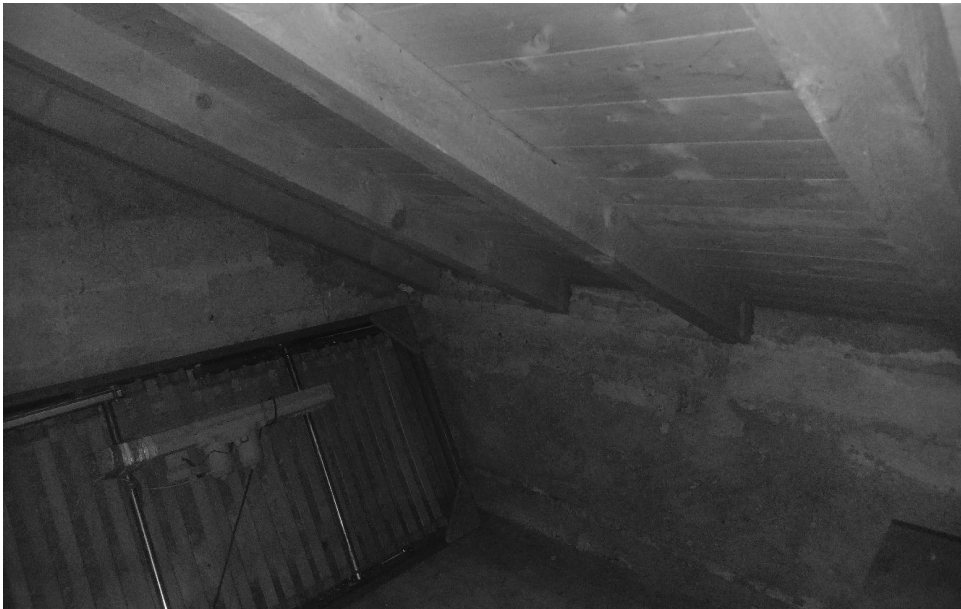
immagine 12: innesto copertura lignea a perimetro
