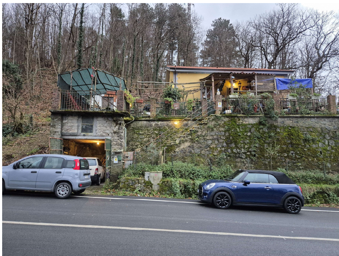
VISTA GENERALE DALLA STRADA
