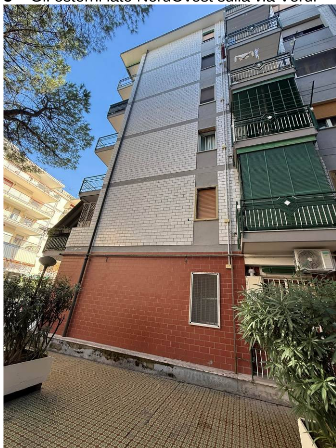
4 – Gli esterni lato Sud Ovest sulla corte aperta del condominio
