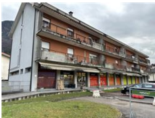
Immagine fronte fabbricato
