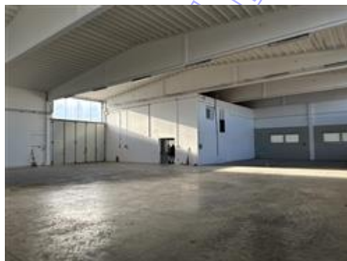
Vista interna capannone verso corpo uffici
