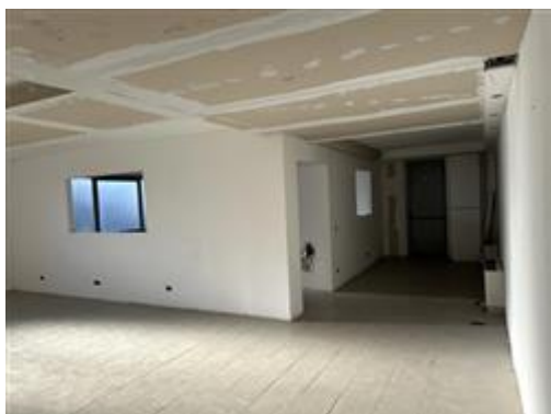
Vista zona interna magazzino al piano terra
