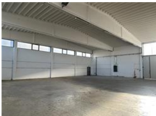
Vista interna capannone al piano terra
