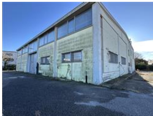
Veduta posteriore capannone
