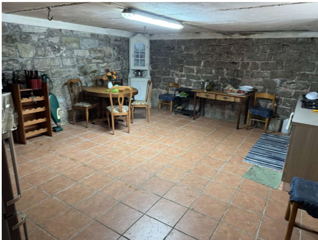
Foto 8 – cantina piano seminterrato
