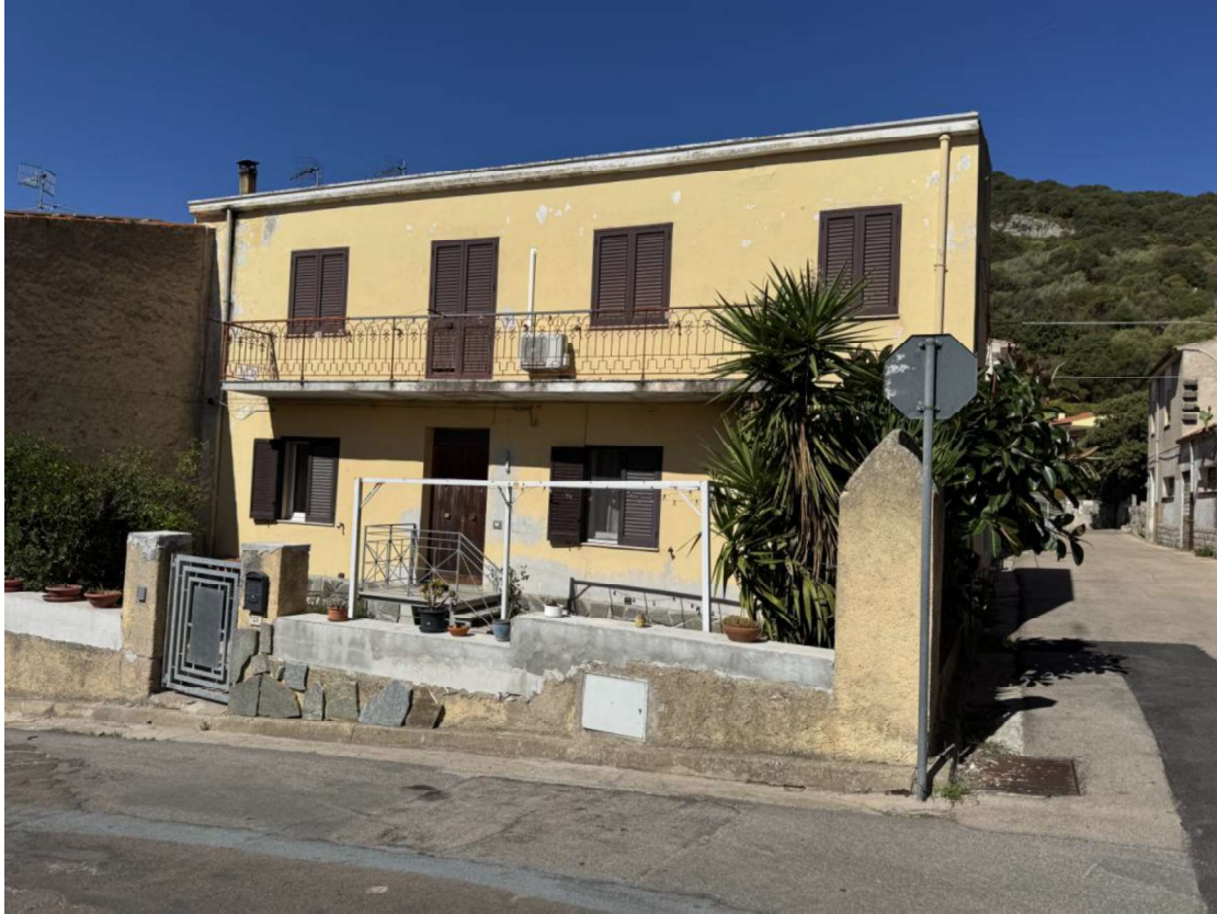
Foto 1 –Ingresso lato strada – Via Rinascita
