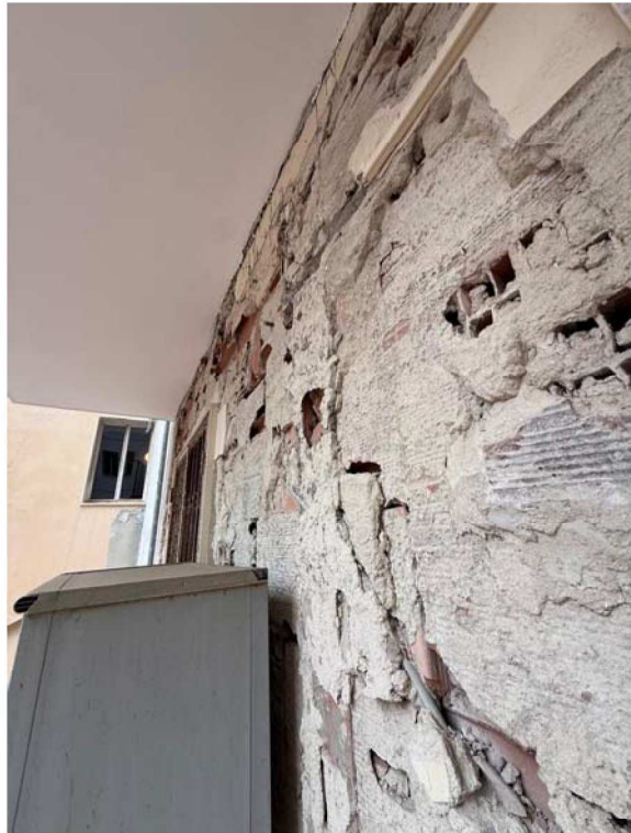
Stato del prospetto esterno
