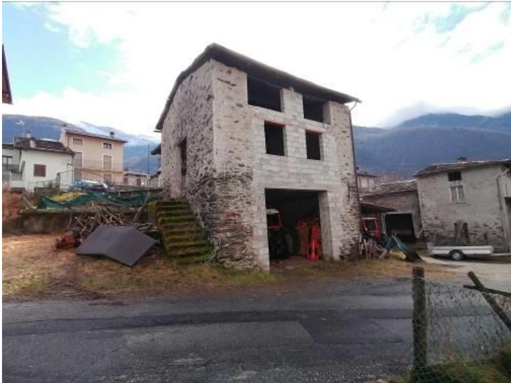
FOTO 1 – fabbricato particella 306 (LOTTO 1)
