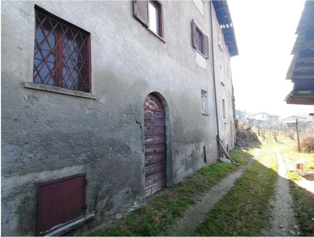
FOTO 7 – accesso alla cantina fabbricato 198 subalterno 1
