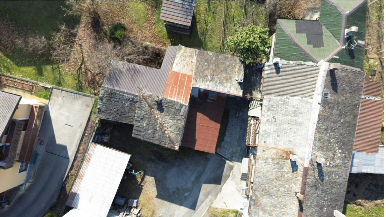
FOTO 3 – vista aerea fabbricato 777-290-291 (LOTTO 2)
