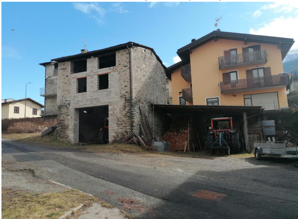
FOTO 2 – fabbricato particella 306 (LOTTO 1)
