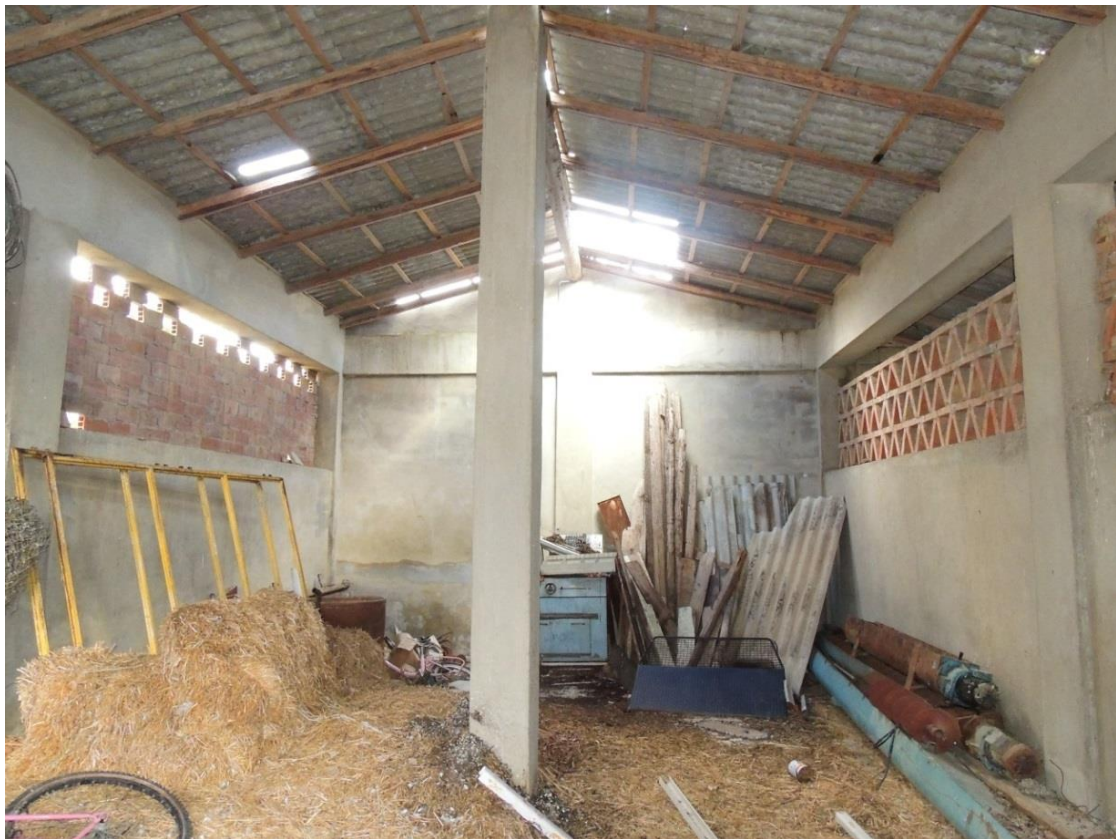
Foto n. 27. Vista interna del magazzino rurale
