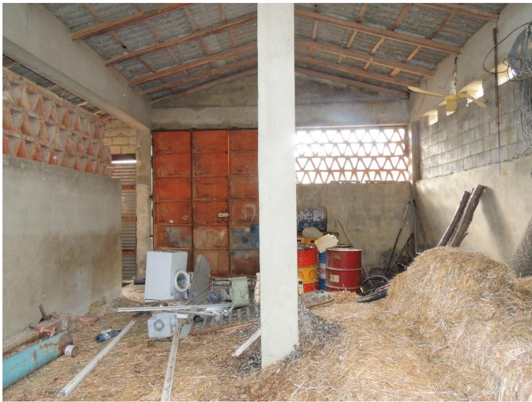
Foto n. 28. Altra vista interna del magazzino rurale
