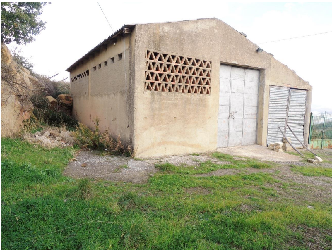
Foto n. 24. Prospetto principale e prospetto laterale
