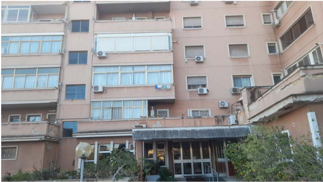
Foto N. 3: Portone d'ingresso al fabbricato di cui fa parte l'immobile
