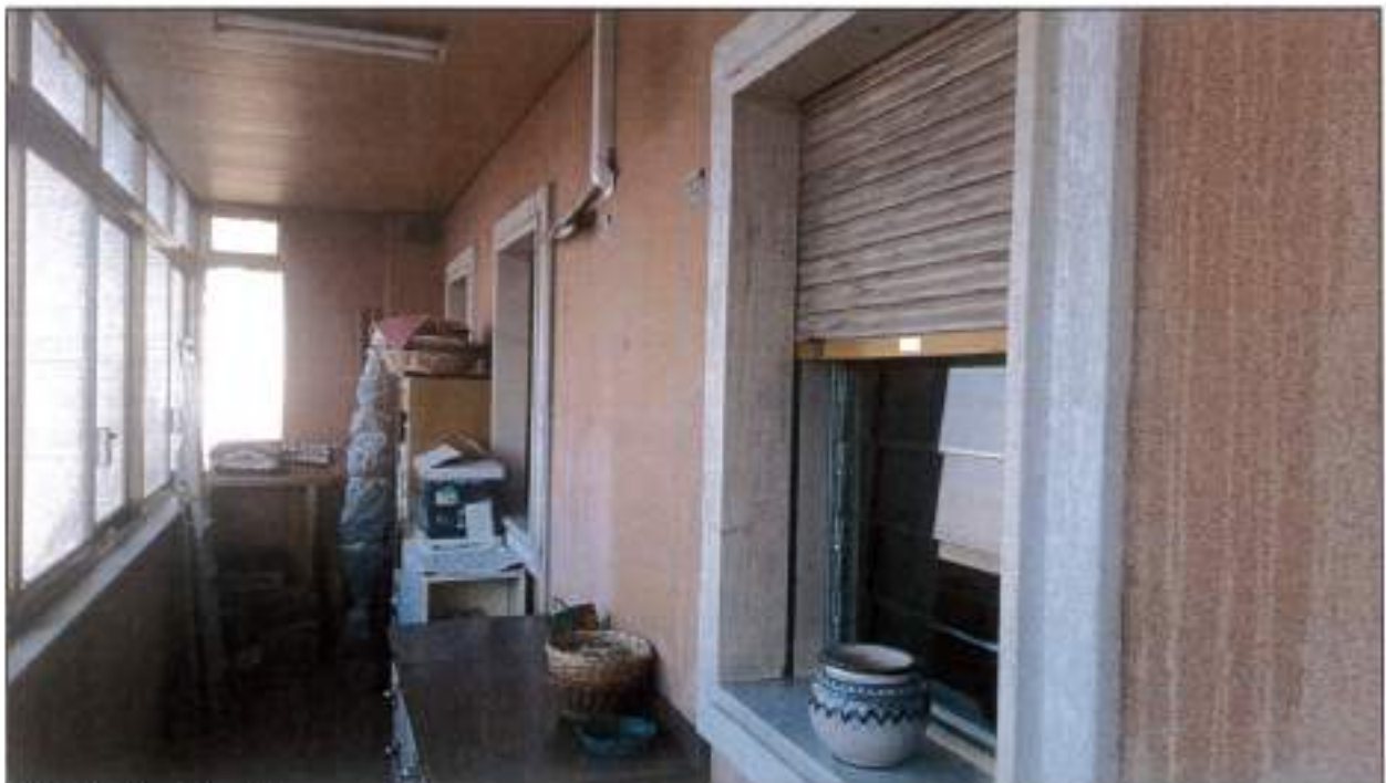
FOTO N. 14: Vista della veranda
