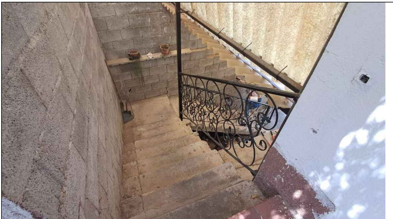
19. Collegamento scale esterne piano T abitazione – piano S1 cantina
