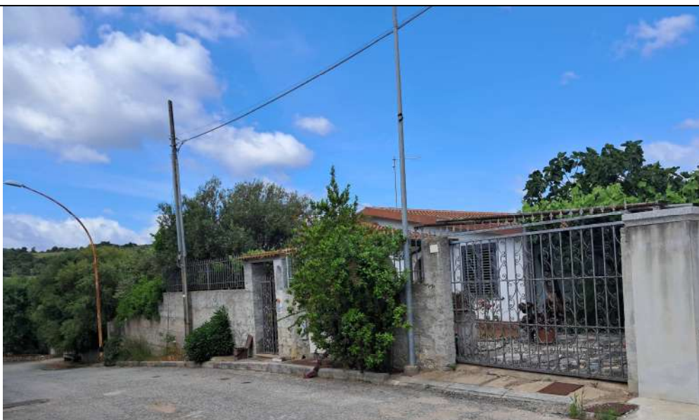
2. Accesso all'abitazione da via Amendola 16 - Oliena (Nu)
