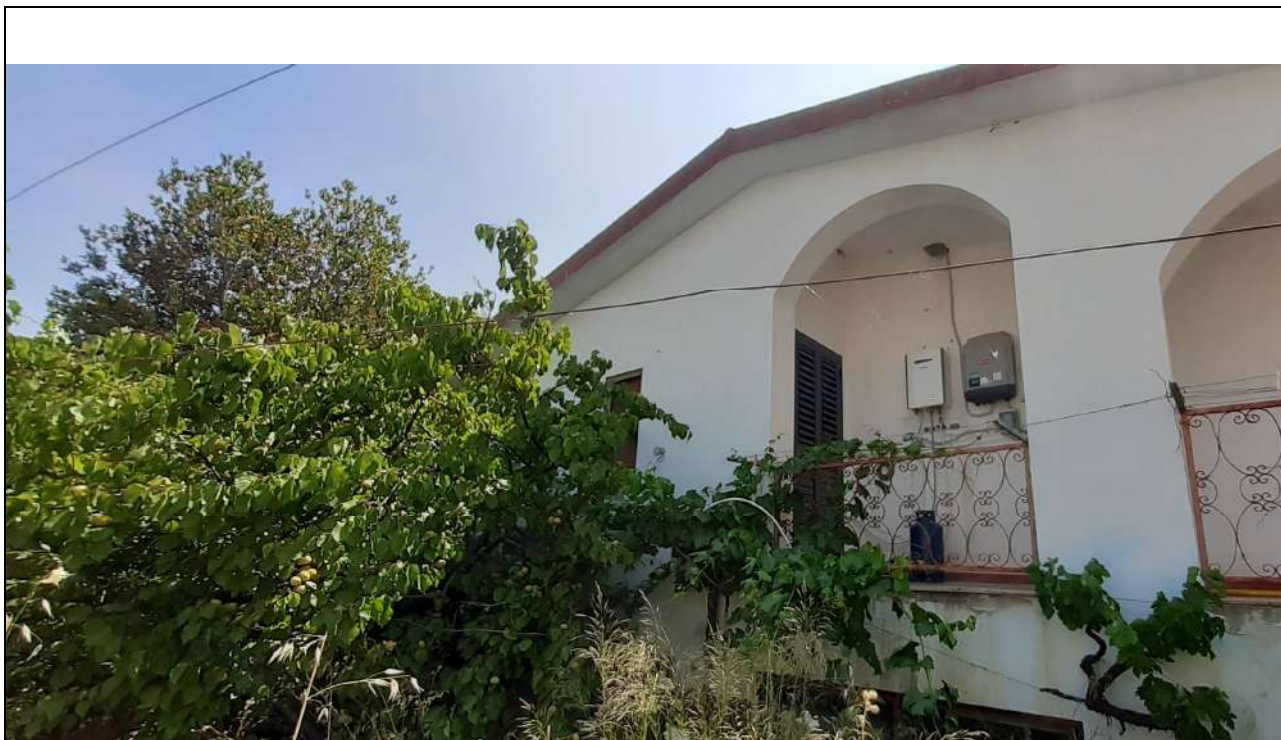
9. Vista Lato Nord-Ovest – parzialmente coperta dalle piante
