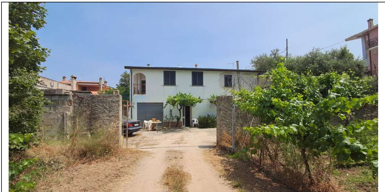
5. Accesso dal terreno al cortile retrostante dell'abitazione – presente muro di recinzione
