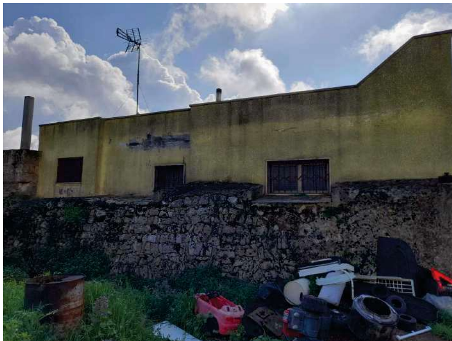
FOTO 4 – prospetto retro nord
