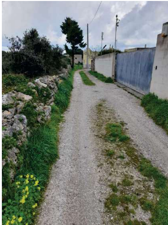
FOTO 1 – strada interpodereale di accesso al lotto
