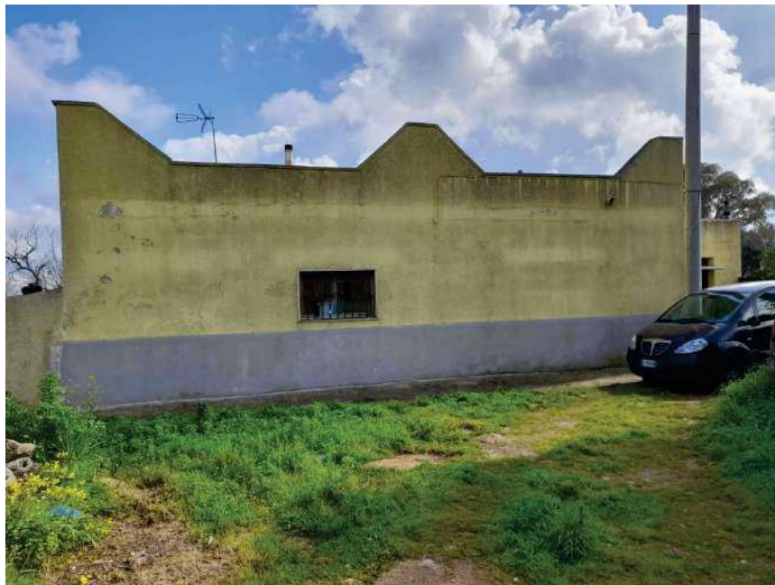
FOTO 2 – strada interpodereale prospetto laterale ovest
