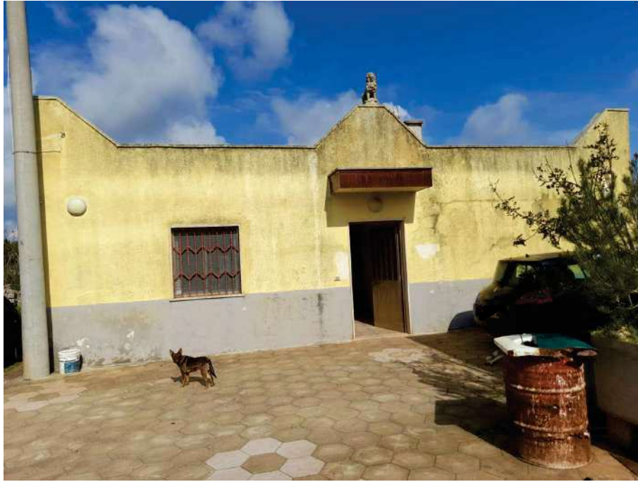
FOTO 3 – prospetto principale sud
