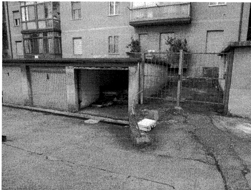
FOTO 3 – Vista contesto lato Ovest
