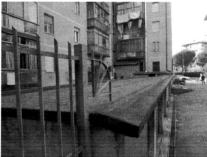
FOTO 2 – Vista della copertura
