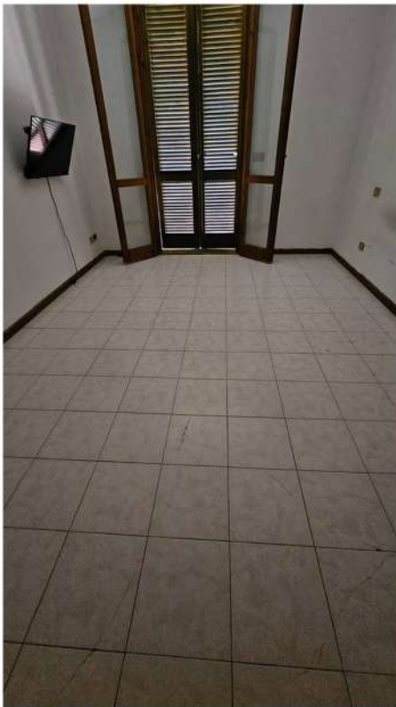
Fotografia del soggiorno del primo piano
