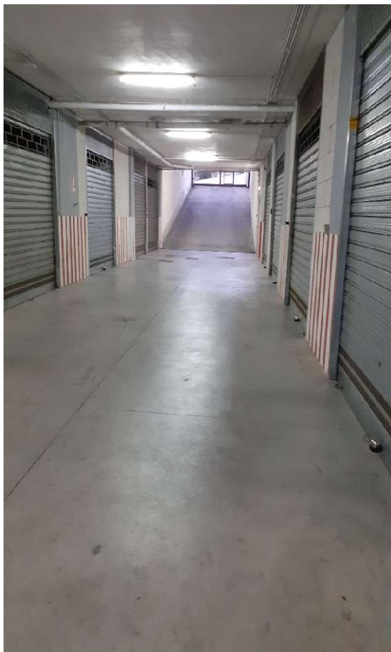
RAMPA DI ACCESSO AL BOX
