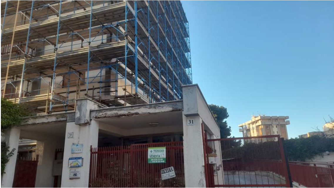
Foto N. 1: Cannello d'ingresso al complesso residenziale su via Paisiello
