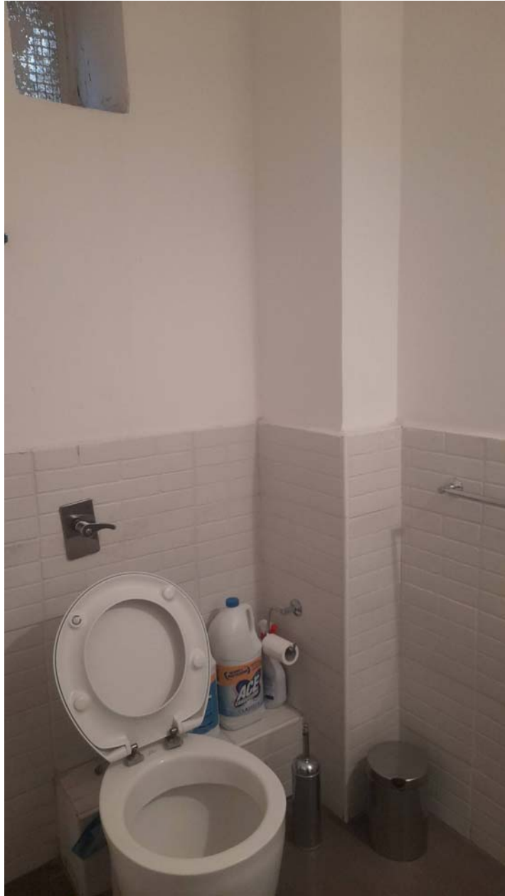
Foto N. 10: Vista del WC principale
