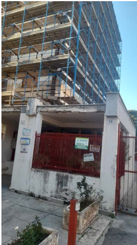
Foto N. 2: Cannello d'ingresso al complesso residenziale su via Paisiello
