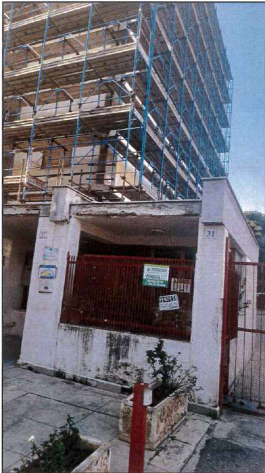
FOTO N. 2: Cancello d'ingresso su via Paisiello
