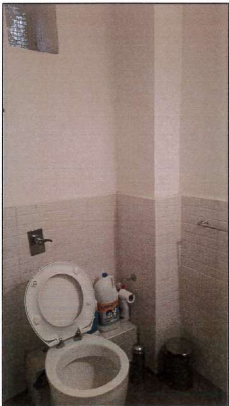
FOTO N. 10: Vista del wc principale
