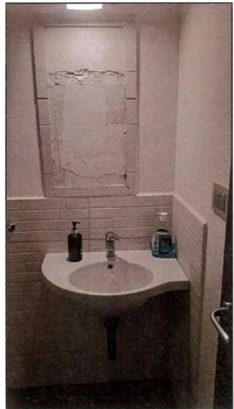
FOTO N. 11: Vista del wc principale
