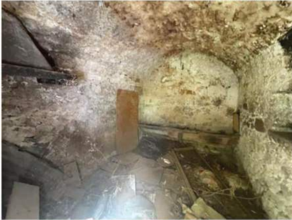
Locale Cantina al piano terra P.Ila 463
