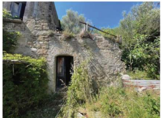
Particolare facciata del fabbricato P.lla 461
