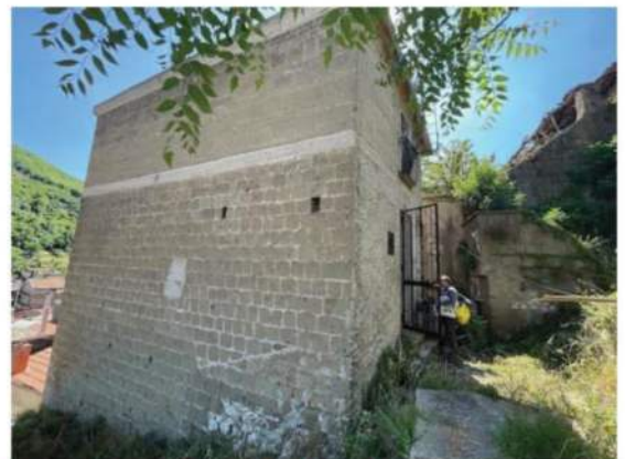
Particolare facciata del fabbricato P.lla 463
