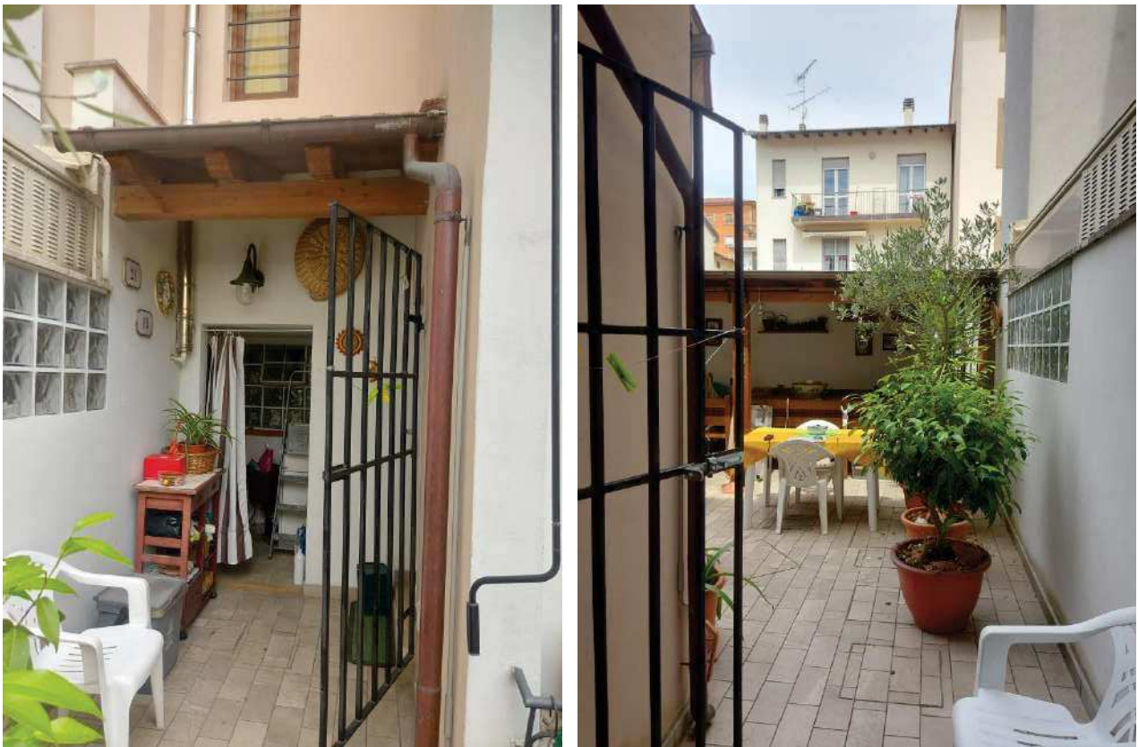
Foto 84: piano terra – resede tergal
