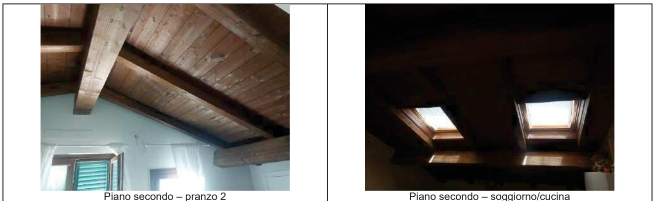
Foto 94: Solai di copertura
