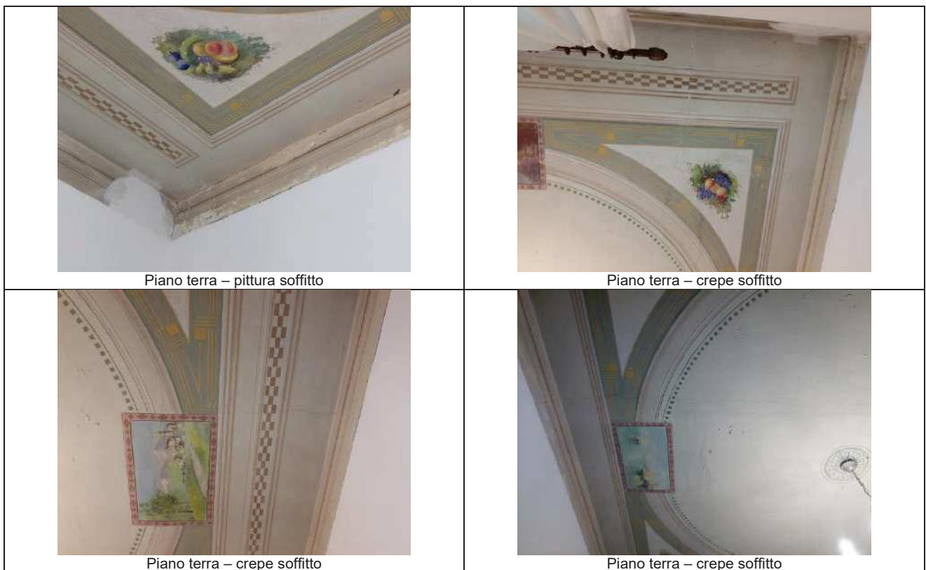
Foto 101: Stato di conservazione
