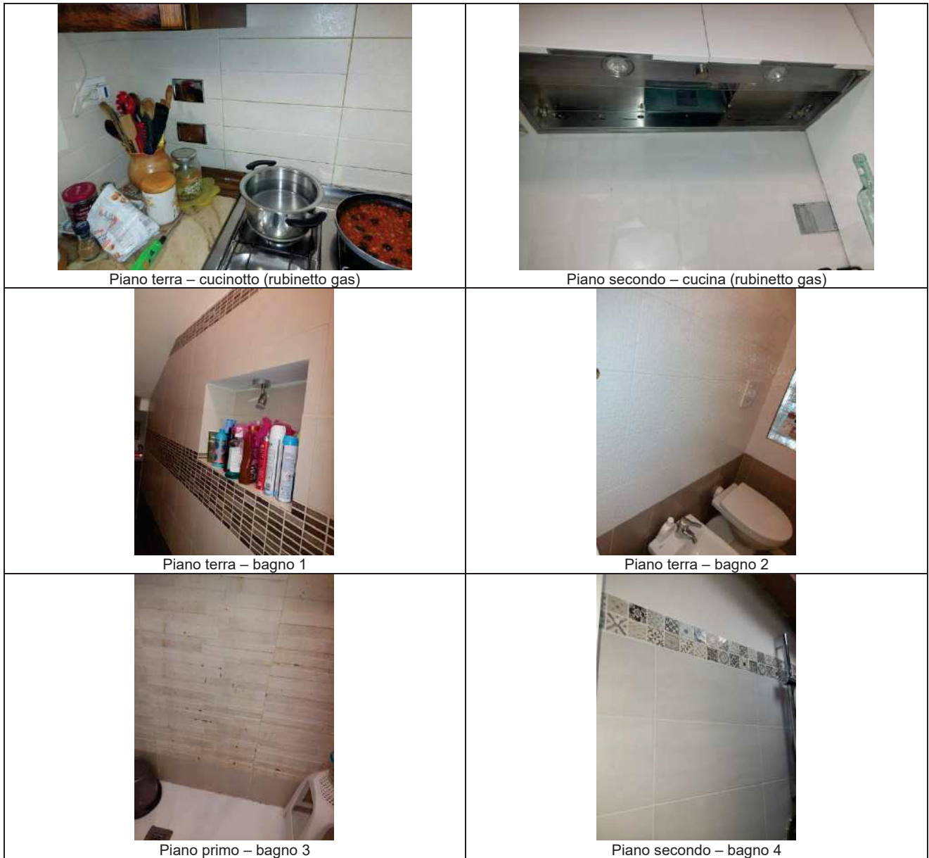
Foto 95: Rivestimenti bagni, cucina e cucinotto
