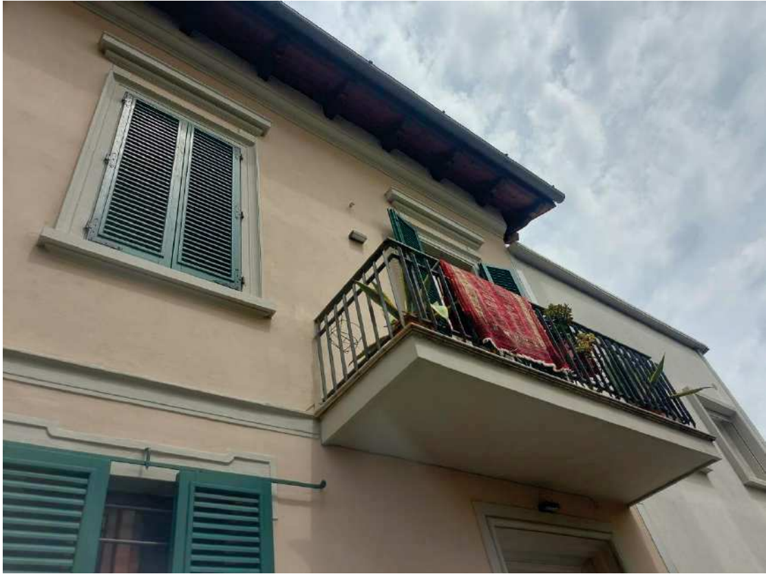
Foto 5: Via Della Robbia – facciata principale – balcone 1
