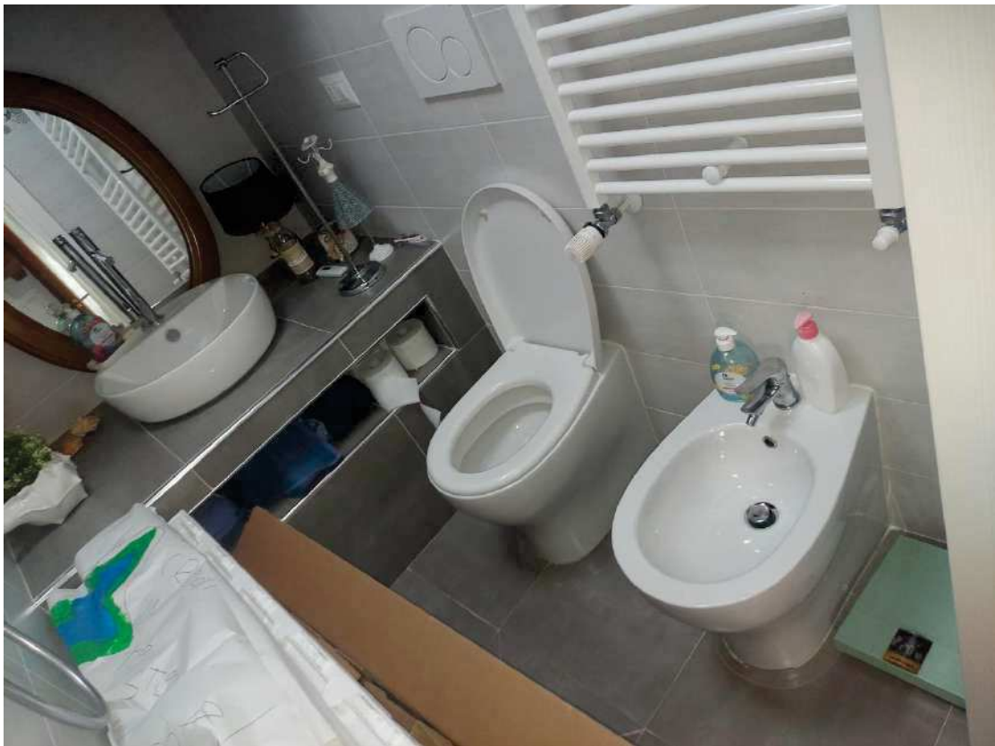
Foto 28: piano secondo – bagno 4
