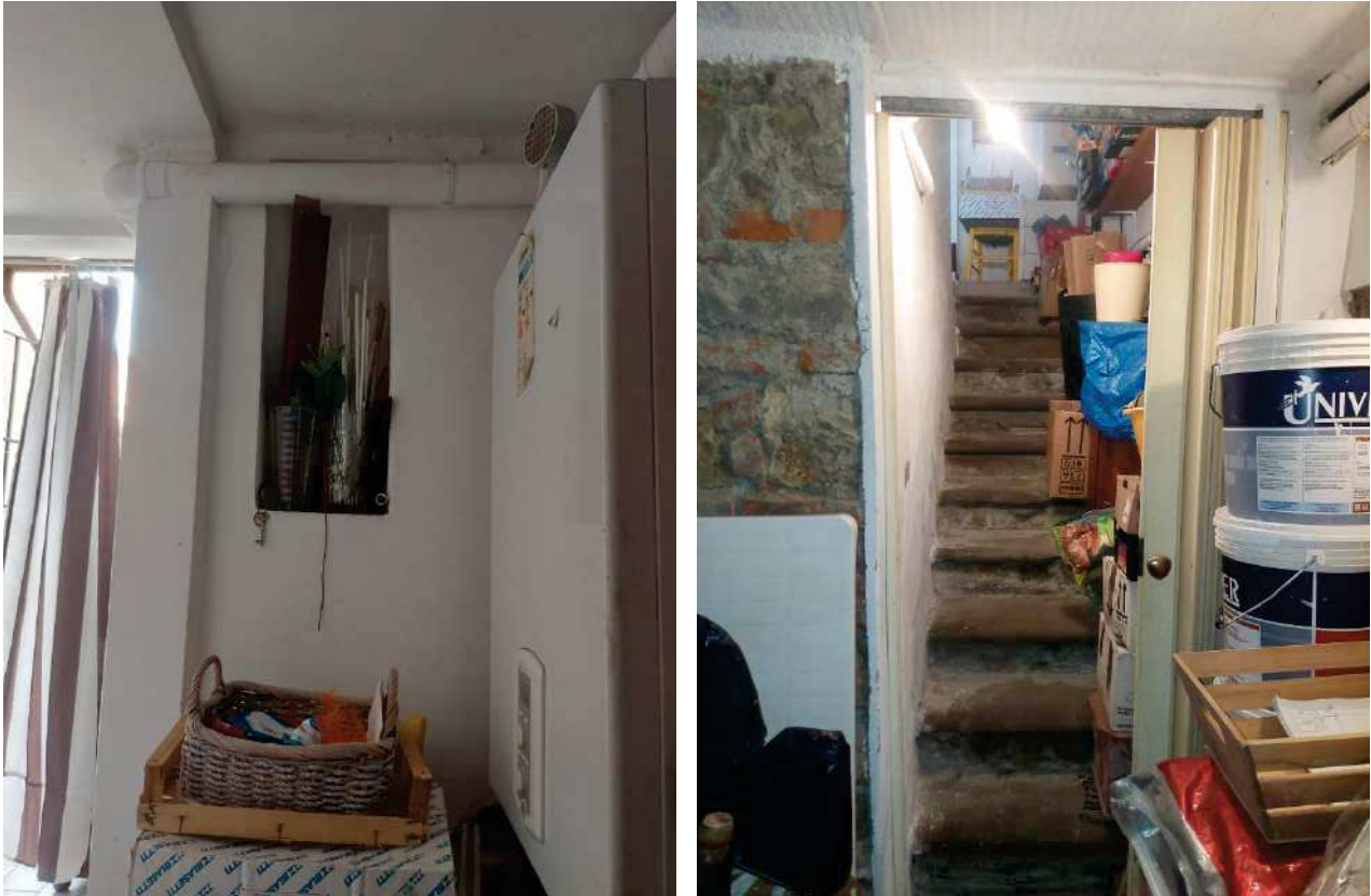
Foto 81: piano terra – disimpegno 3 e scale di accesso alla cantina
