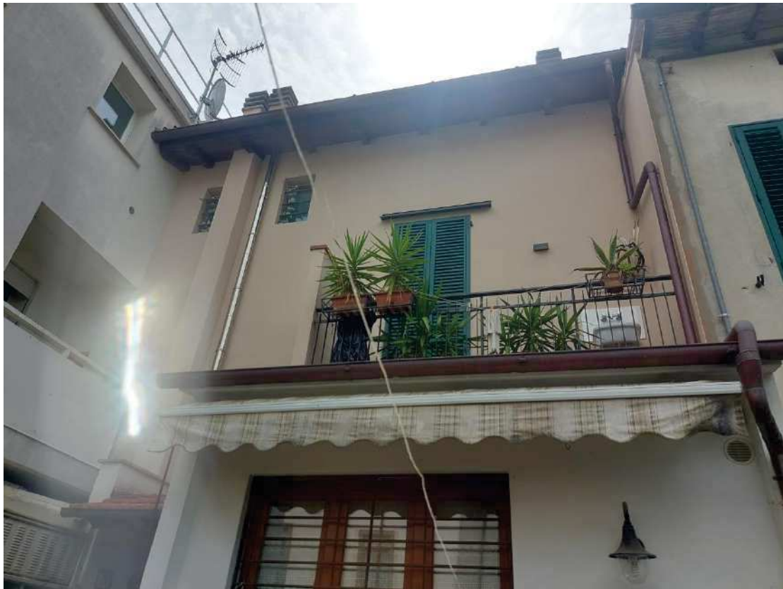
Foto 87: piano terra – resede tergale – balcone 2
