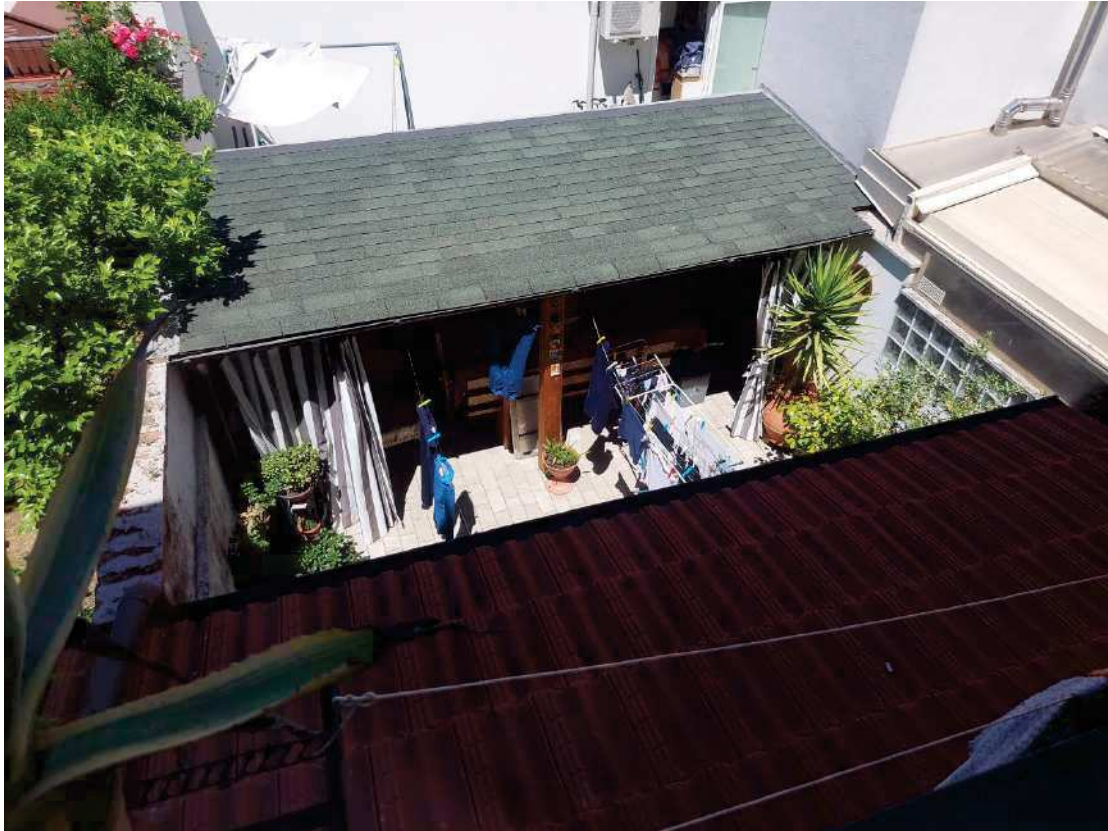
Foto 47: piano primo – balcone 2 – vista su resede tergale
