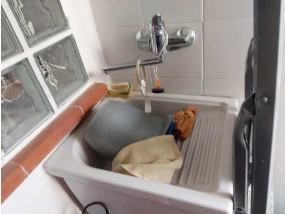
Foto 79: piano terra – disimpegno 3 - pilozzo
