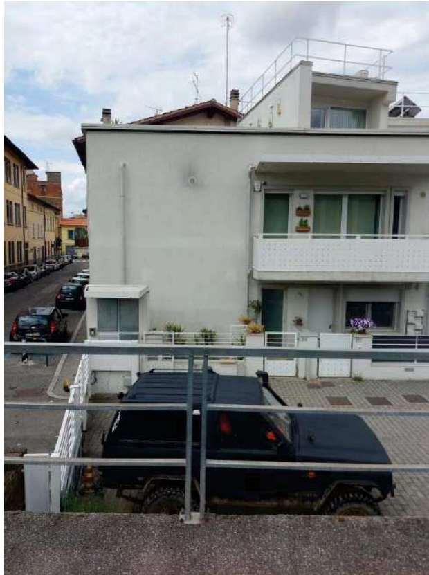
Foto 7: Vista dalla pista ciclabile - resede carrabile – Posto Sub.508
