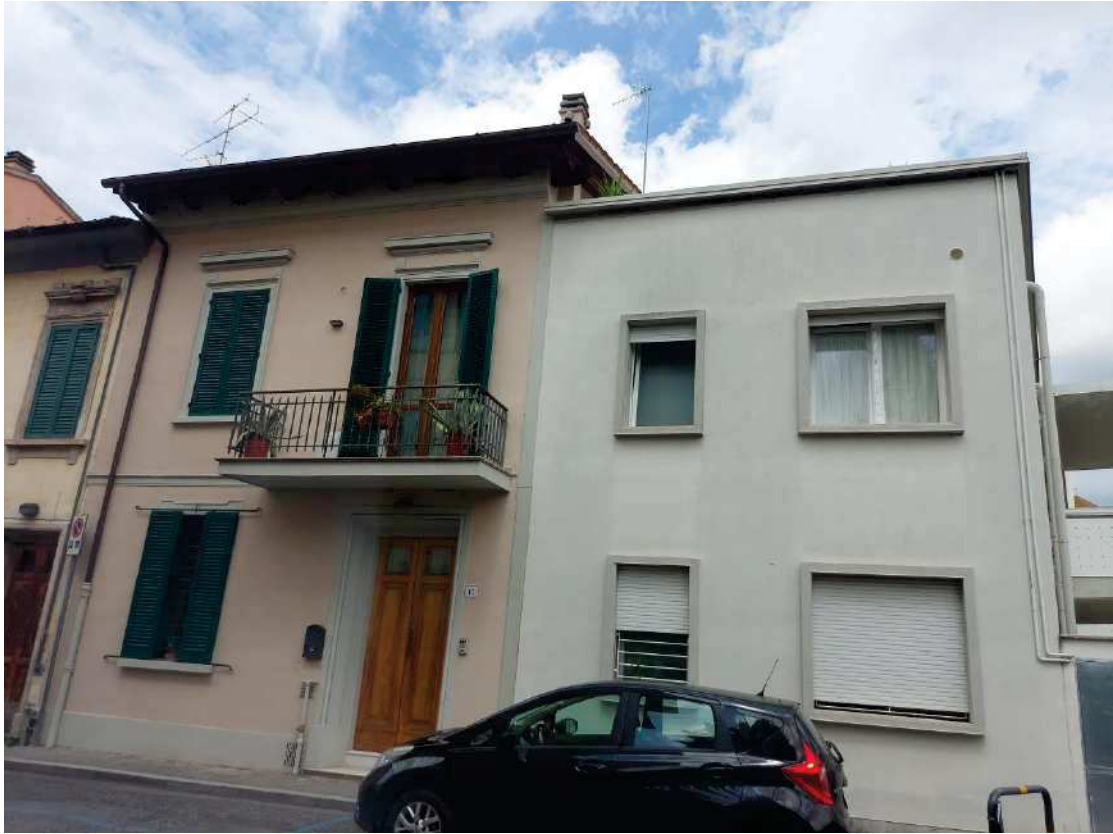
Foto 3: Via Della Robbia – facciata principale
