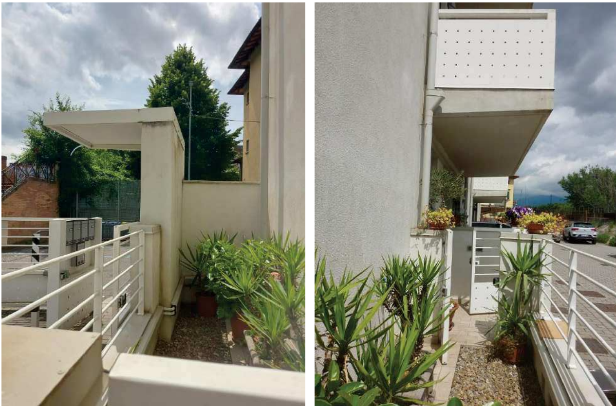
Foto 10: piano secondo – resede laterale
