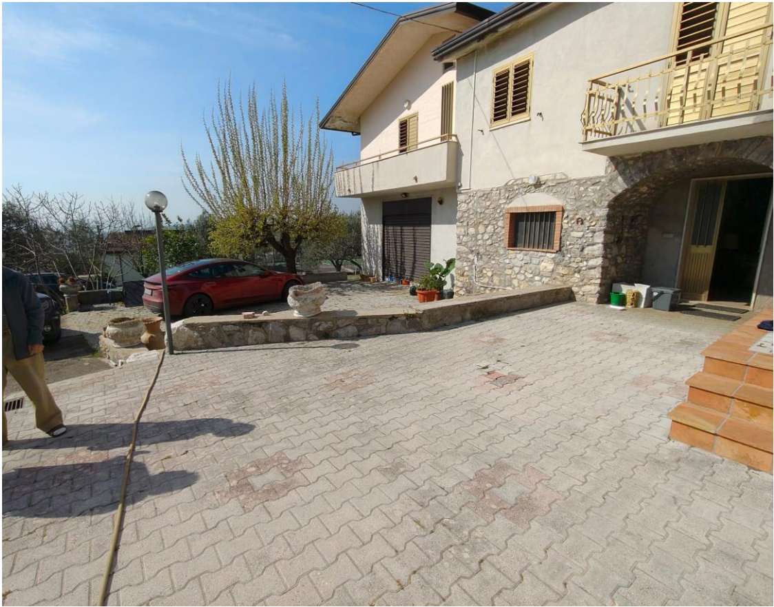
Foto n. 5 Area di pertinenza al fabbricato
