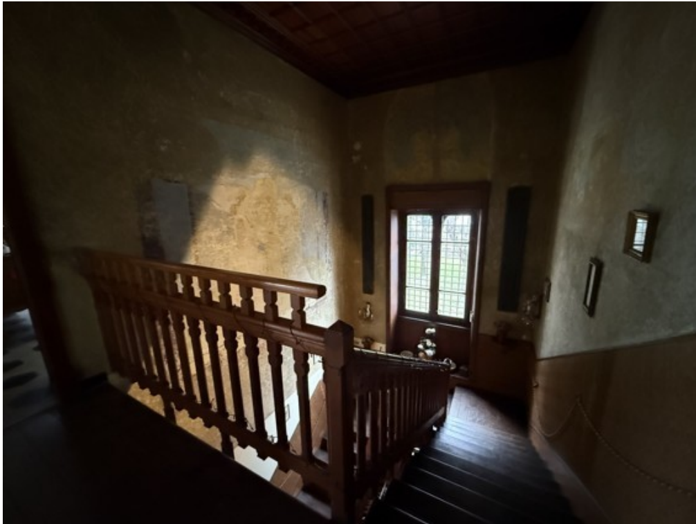
Fotografia A.23 - Scalone interno
