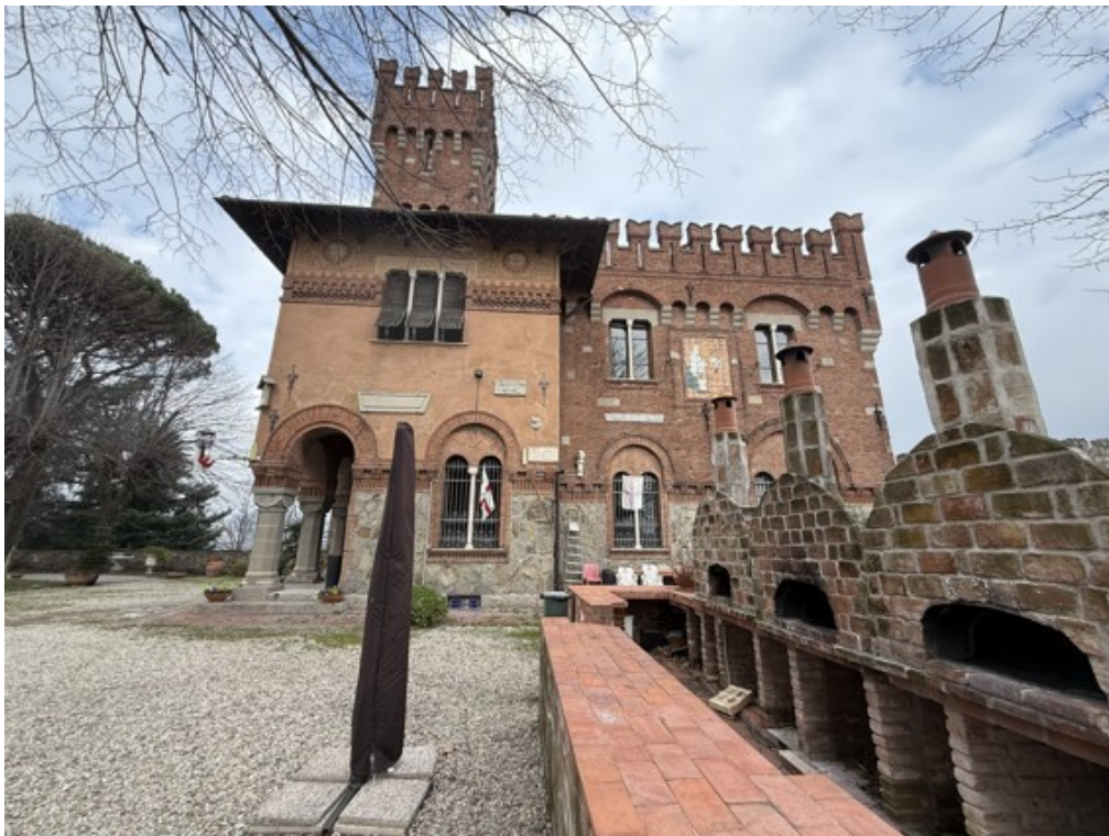
Fotografia A.8 - Esterni
