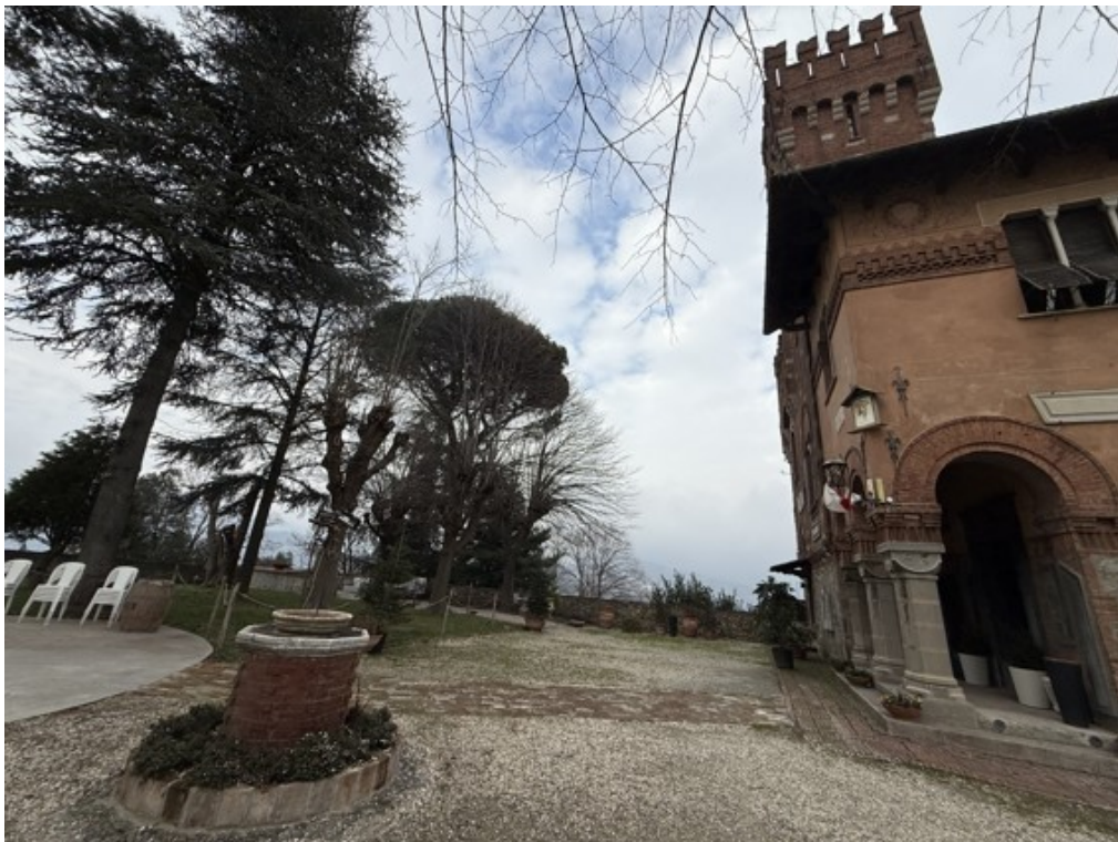
Fotografia A.6 - Esterni
