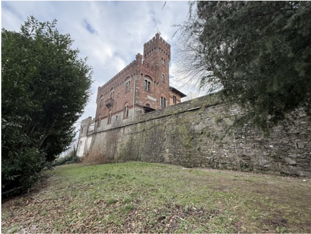
Fotografia A.1 - Esterni
