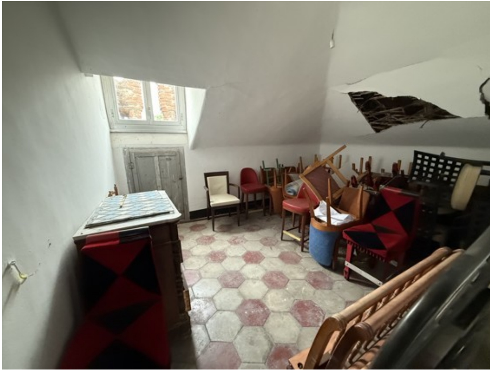
Fotografia A.21 - Soffitta
