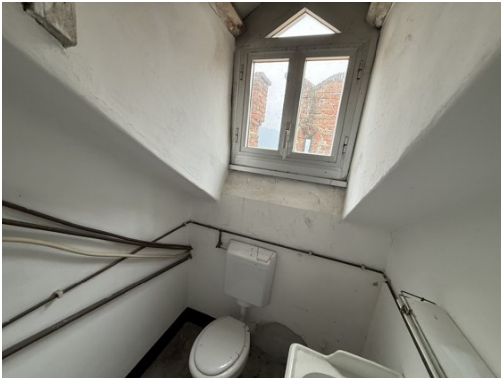
Fotografia A.22 - Soffitta
