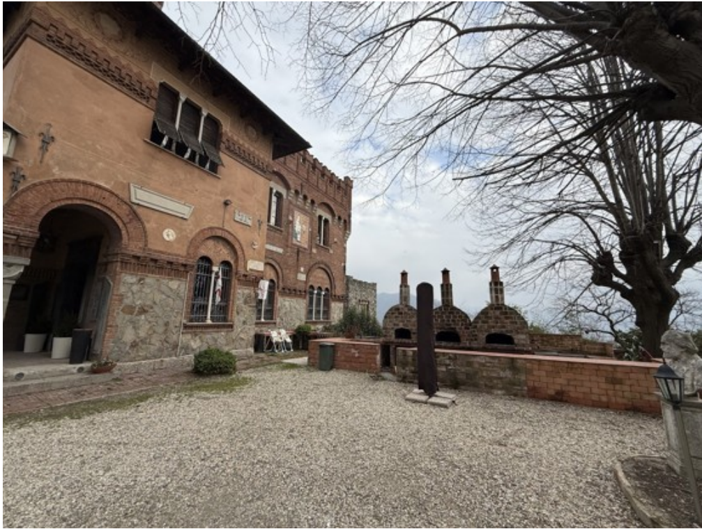
Fotografia A.7 - Esterni
