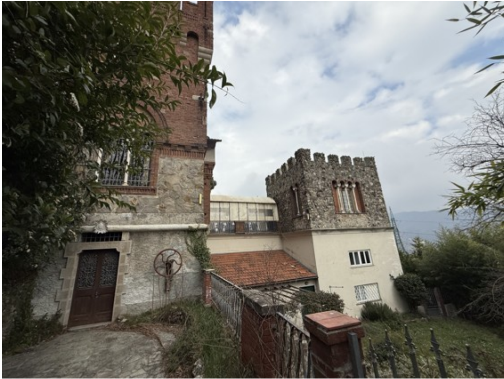
Fotografia A.9 - Esterni
