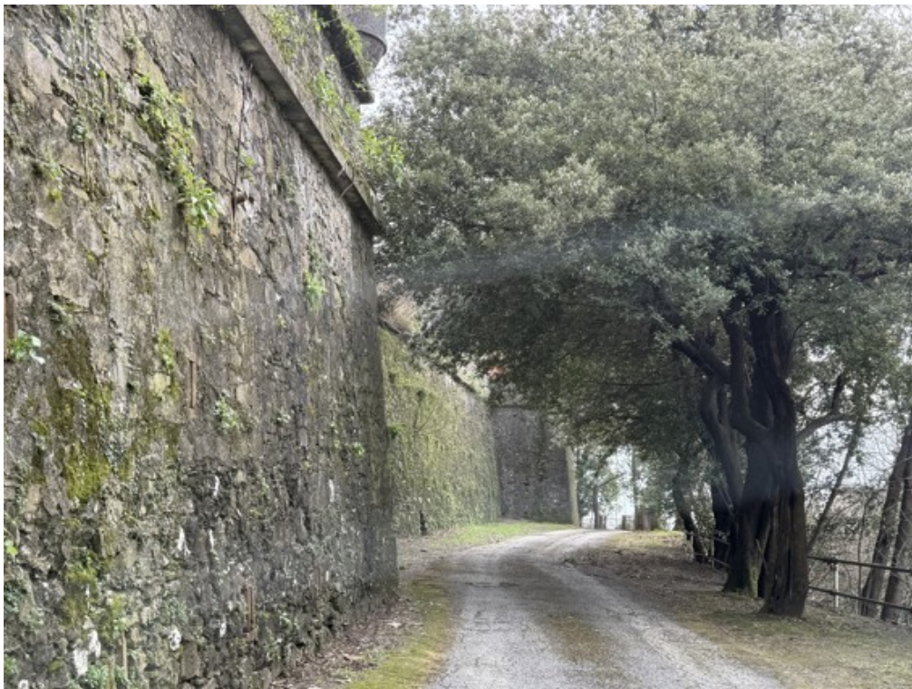
Fotografia A.2 - Viale accesso
