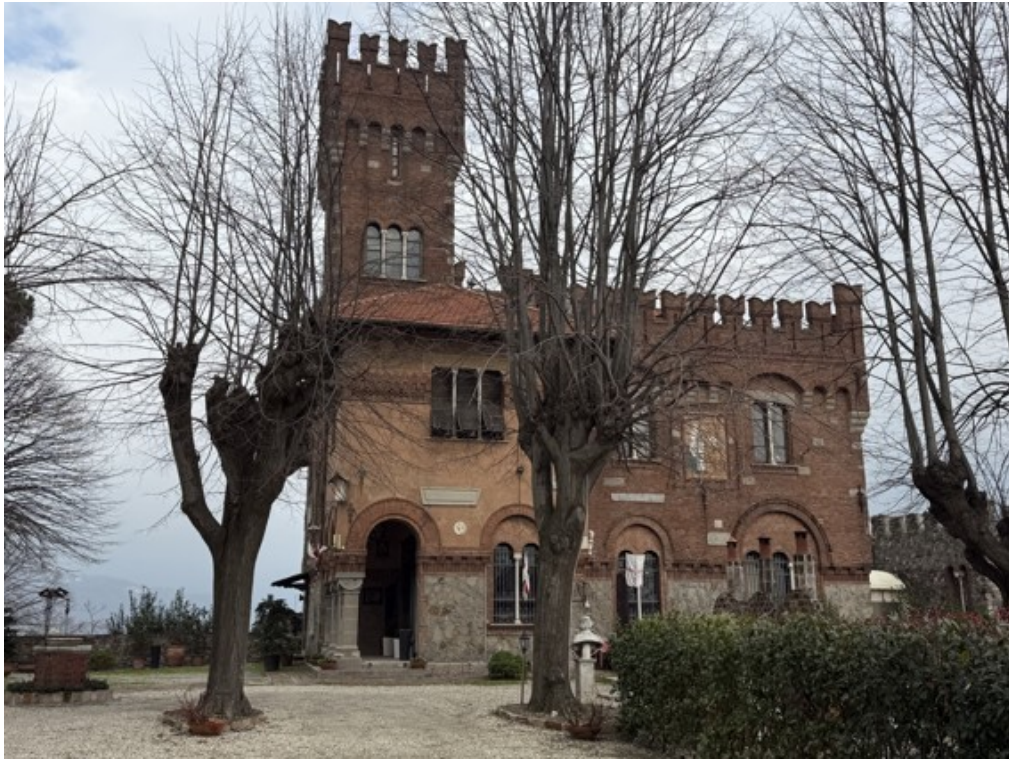
Fotografia A.3 - Esterni
