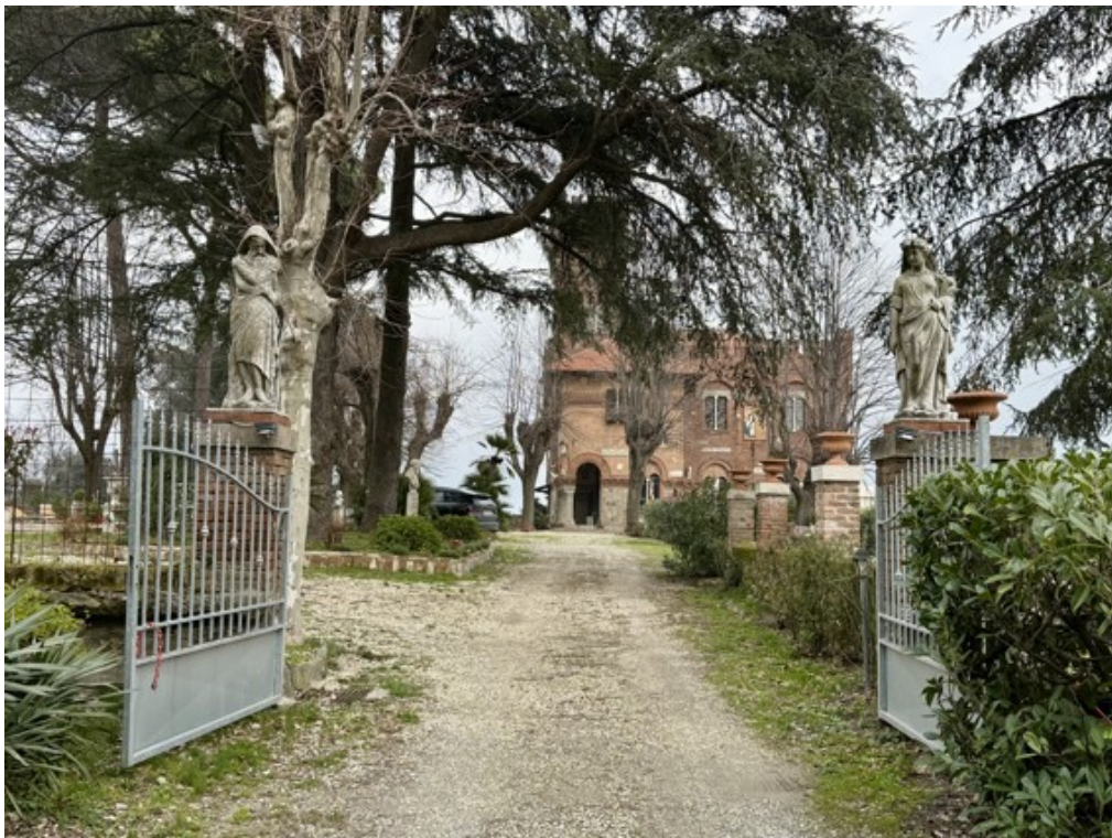
Fotografia A.14 - Esterni
