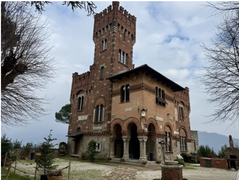
Fotografia A.4 - Esterni
