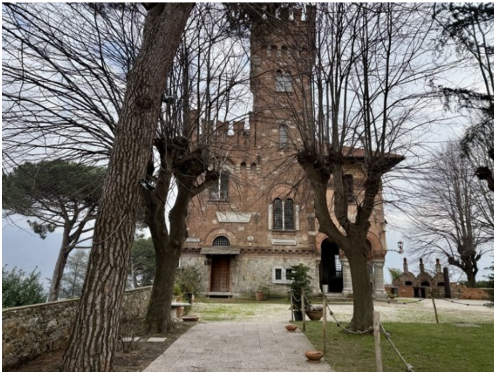
Fotografia A.10 - Esterni
