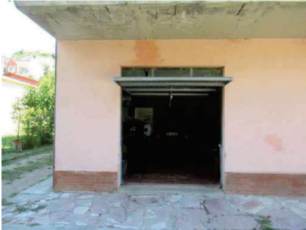
Foto n. 19: Porta d'accesso al garage
