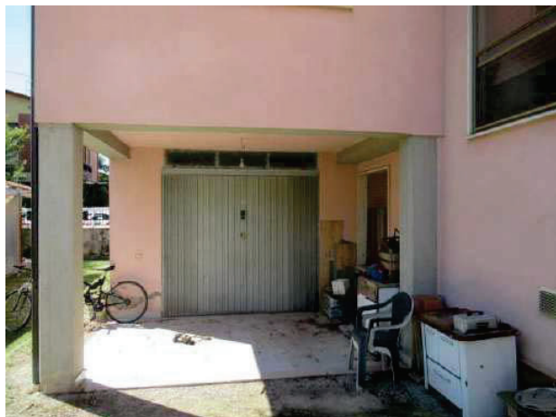
Foto n. 29: Porta d'accesso al garage
