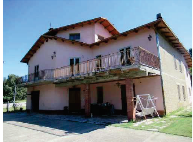
Foto n. 2: Facciata Ovest del fabbricato
