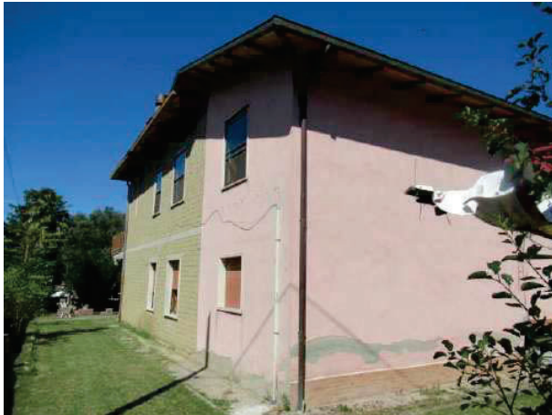
Foto n. 3: Facciata Sud del fabbricato
