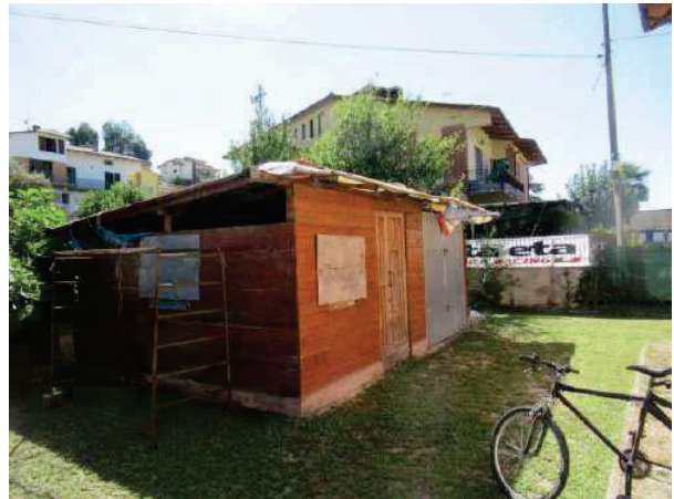
Foto n. 10: Manufatto da demolire
