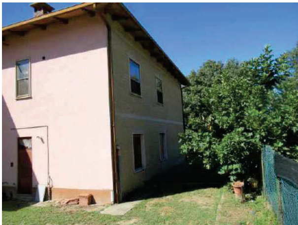
Foto n. 5: Facciata Nord del fabbricato
