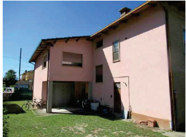
Foto n. 4: Facciata Est del fabbricato
