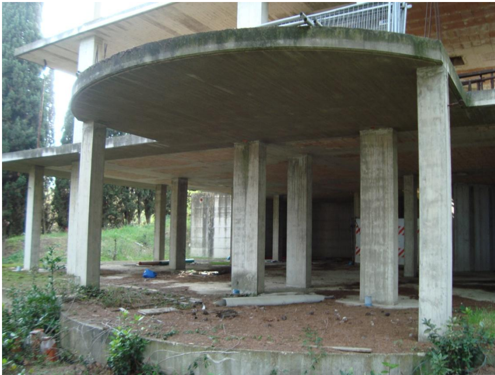
FOTO N.6 : PARTICOLARE PROSPETTO EST PIANI S.1. E TERRA
