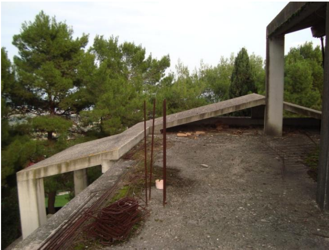
FOTO N. 13 – PIANO 2°SOTTOTETTO E COPERTURA
