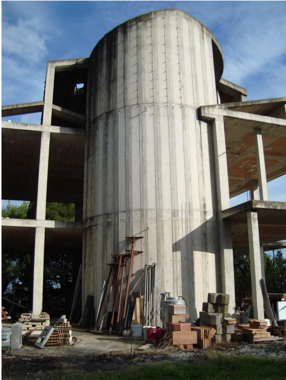
FOTO N. 7 - VANO SCALA CIRCOLARE IN C.A. SUL PROSPETTO OVEST
