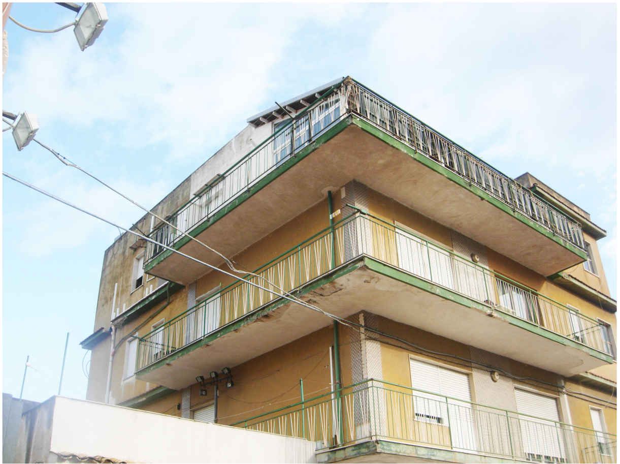
Foto n. 27 - Bene n. 4: Appartamento, Strada Statale 113, n. 219, Carini (PA)
