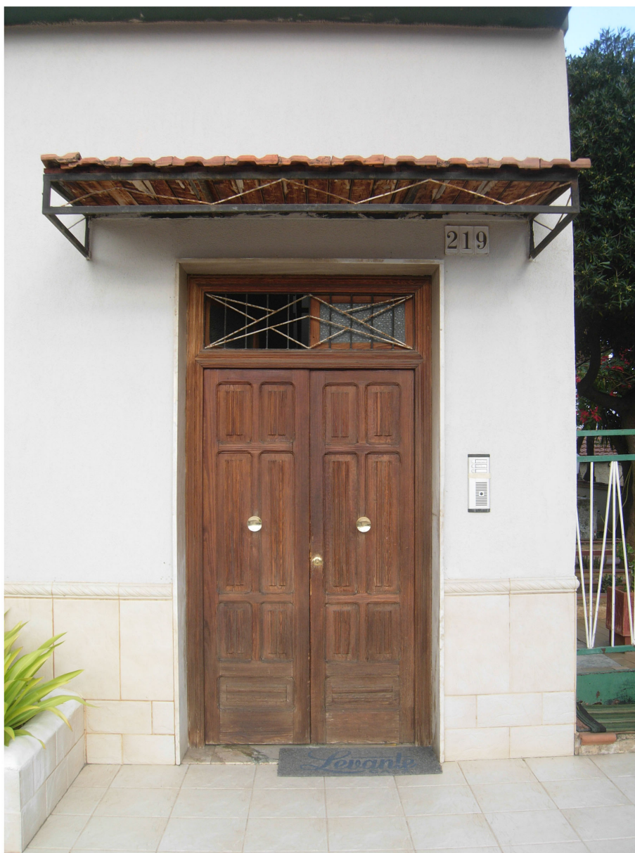
Foto n. 18 - Bene n. 4: Appartamento, Strada Statale 113, n. 219, Carini (PA)
