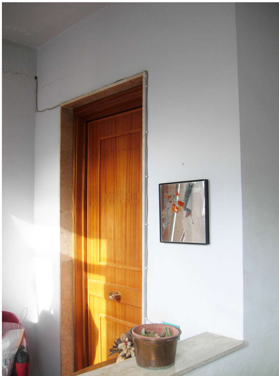
Foto n. 19 - Bene n. 4: Appartamento, Strada Statale 113, n. 219, Carini (PA)
