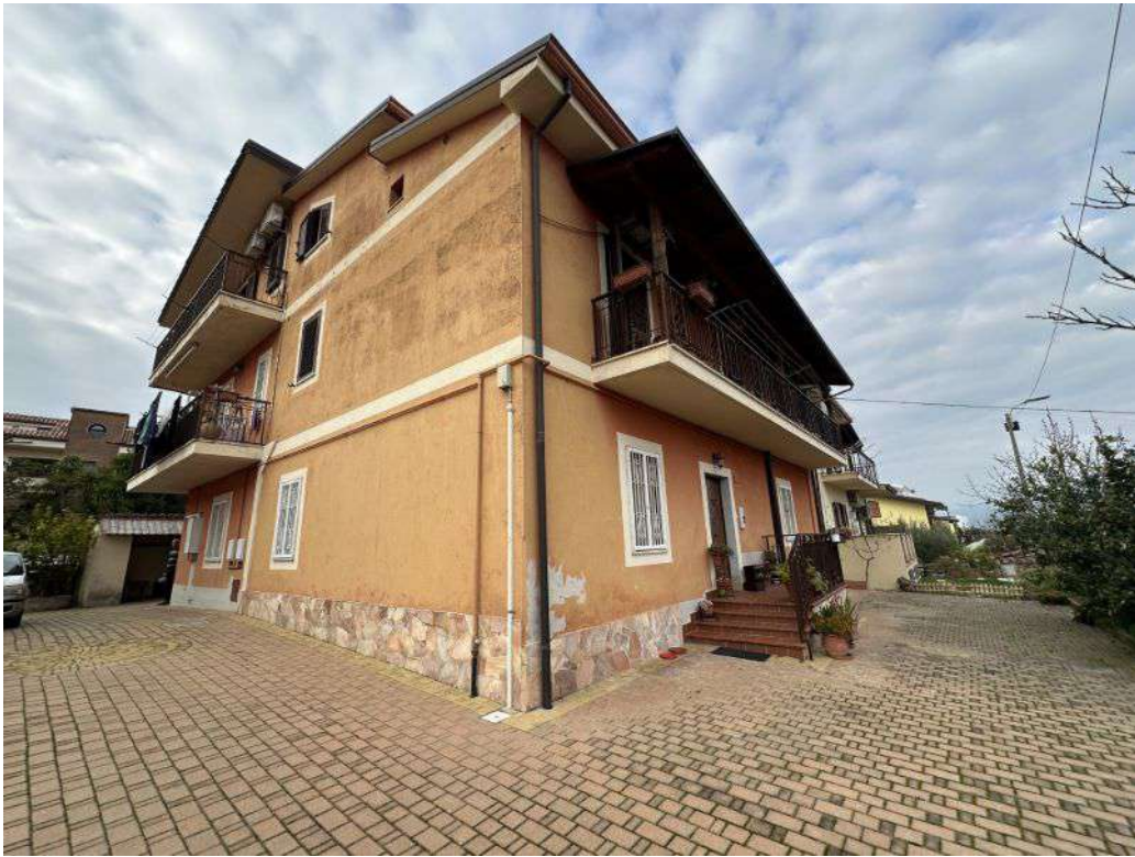
Foto 1: Vista esterna immobile.
