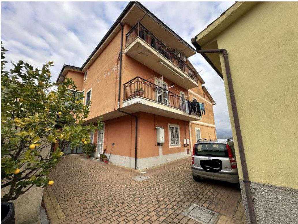
Foto 2: Vista esterna immobile.
