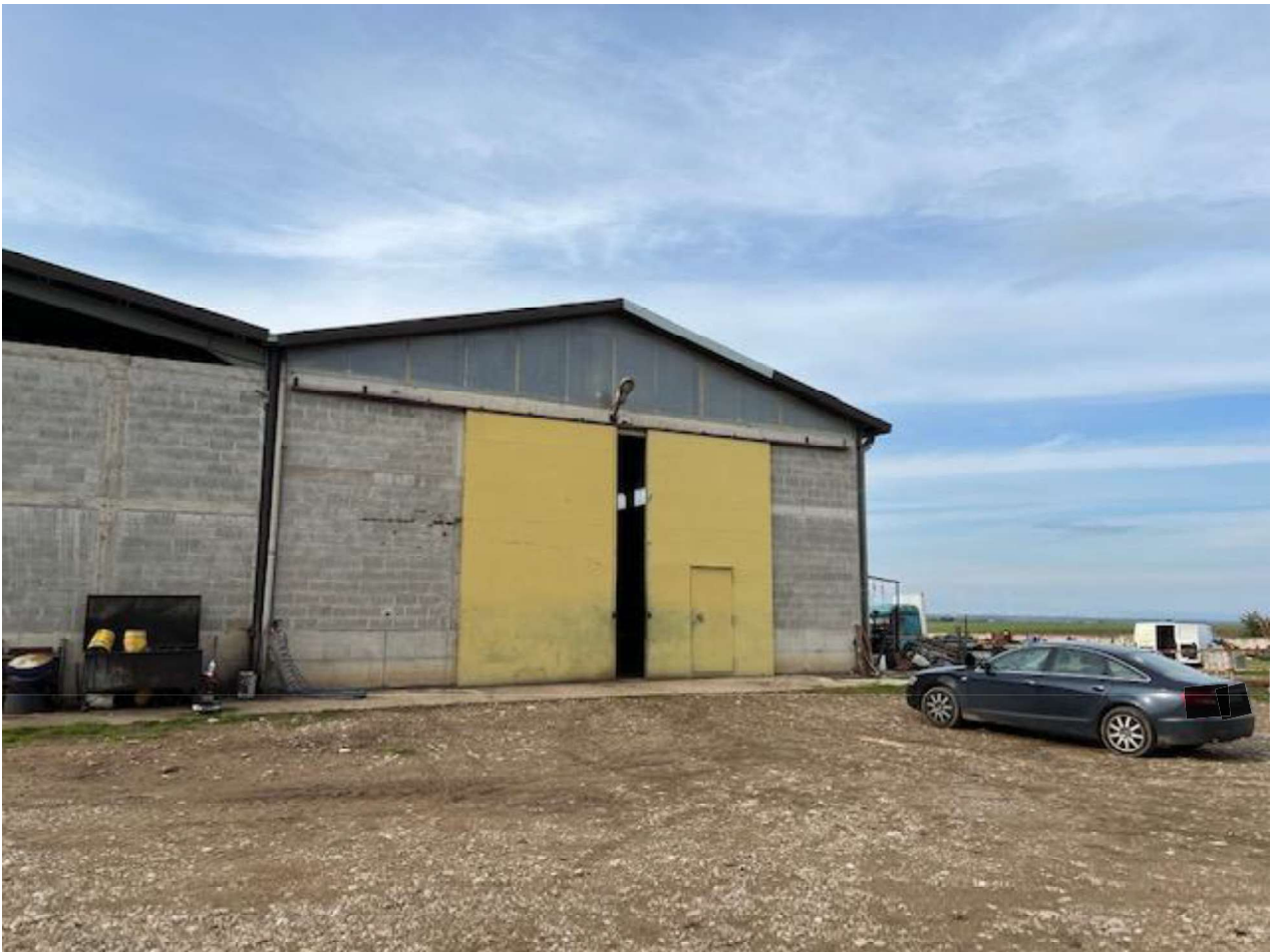
Figura 4 – Panoramica Capannoni, foglio 14, p.lla 418, sub 1.
