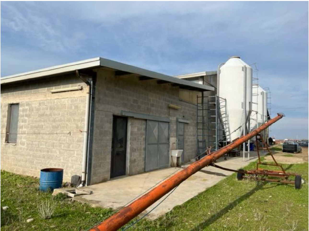
Figura 7 – Panoramica Capannoni, foglio 14, p.lla 418, sub 1.
