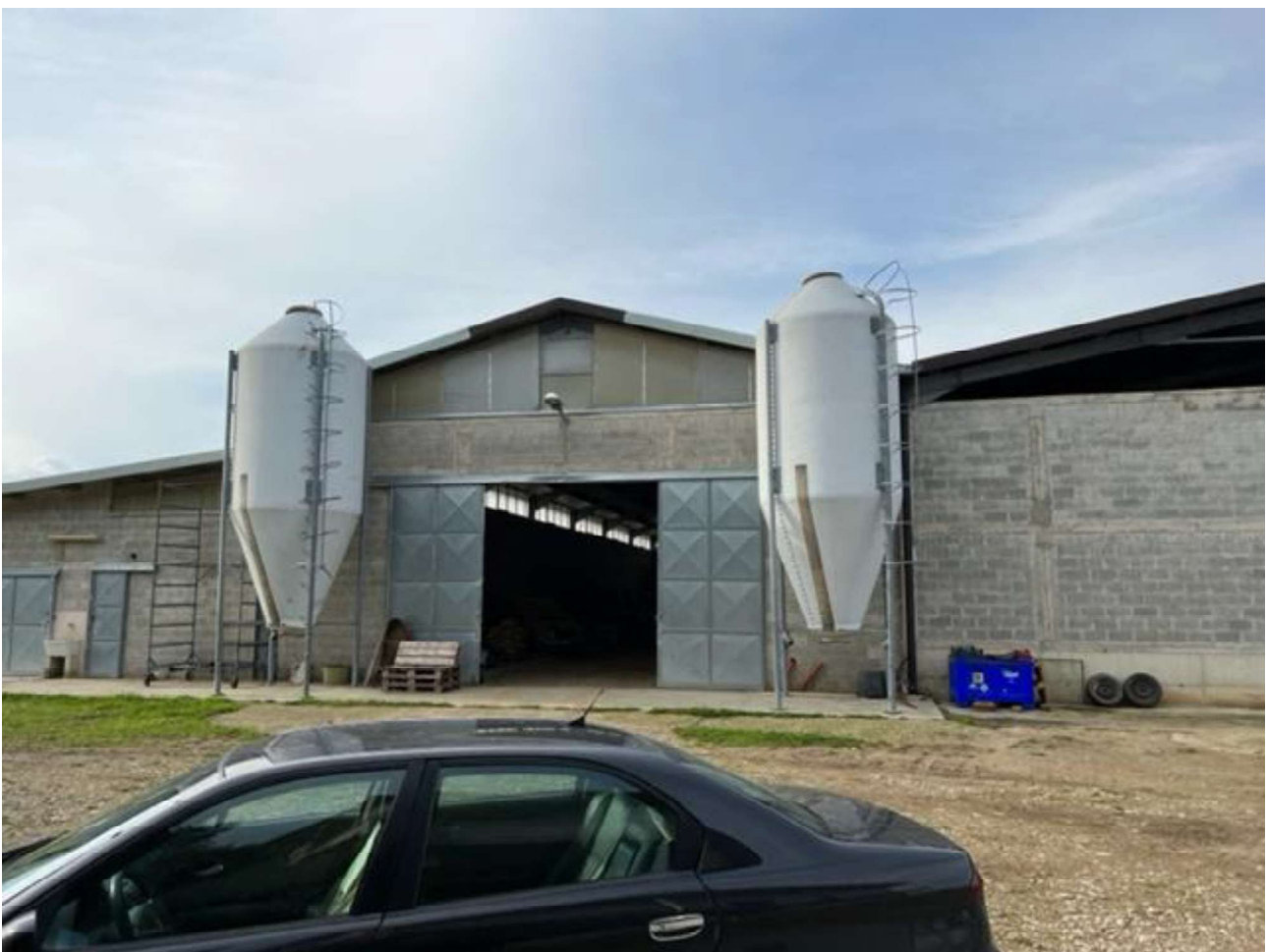
Figura 6 – Panoramica Capannoni, foglio 14, p.lla 418, sub 1.
