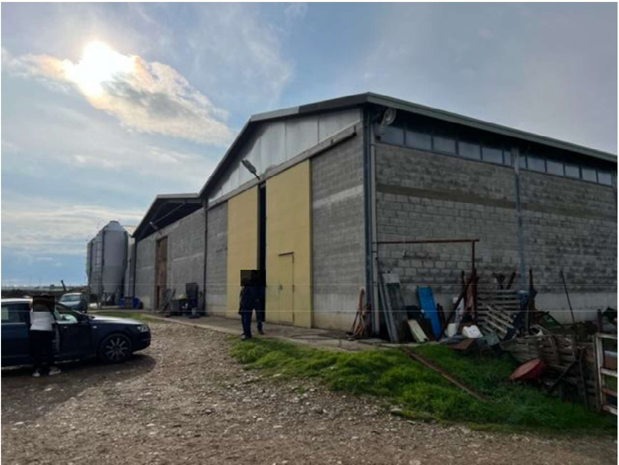
Figura 3 – Panoramica Capannoni, foglio 14, p.lla 418, sub 1.
