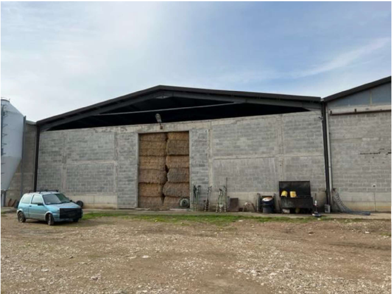
Figura 5 – Panoramica Capannoni, foglio 14, p.lla 418, sub 1.
