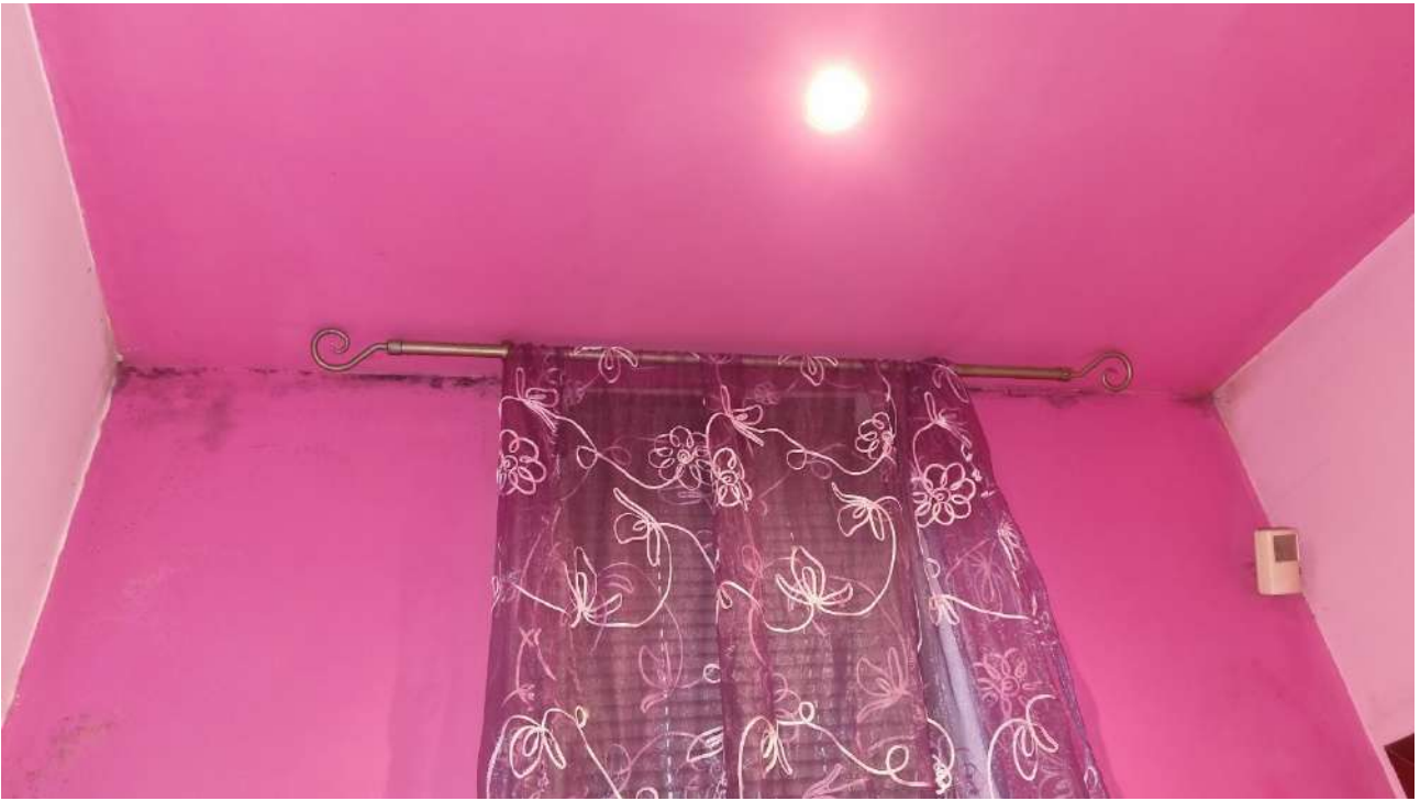
20251118_104530 – Piano 1° – Vano Scala / Corridoio
