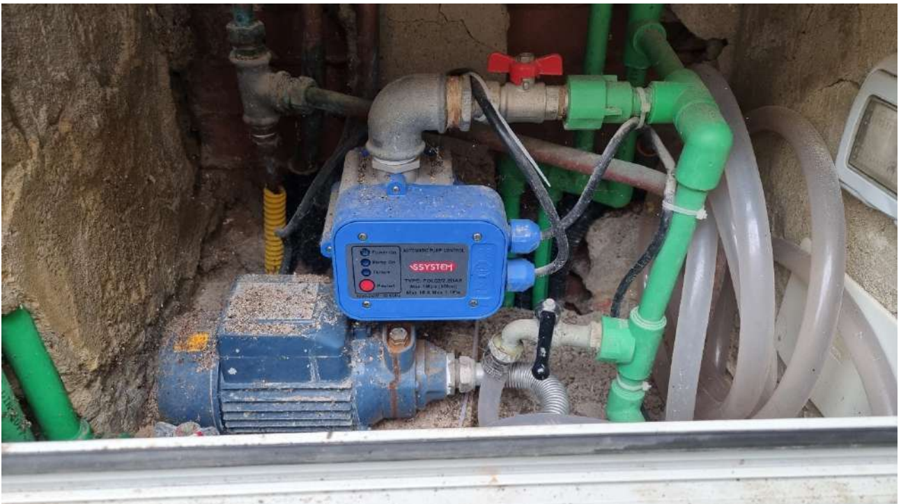
20251118_101847– Esterno – Via San Sebastiano – Vano Caldaia
