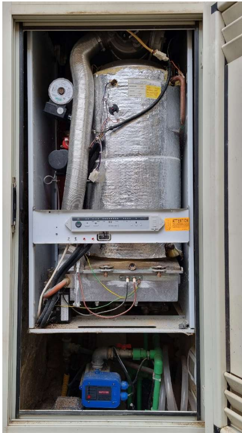
2025118_101820 – Esterno – Via San Sebastiano – Vano Caldaia
