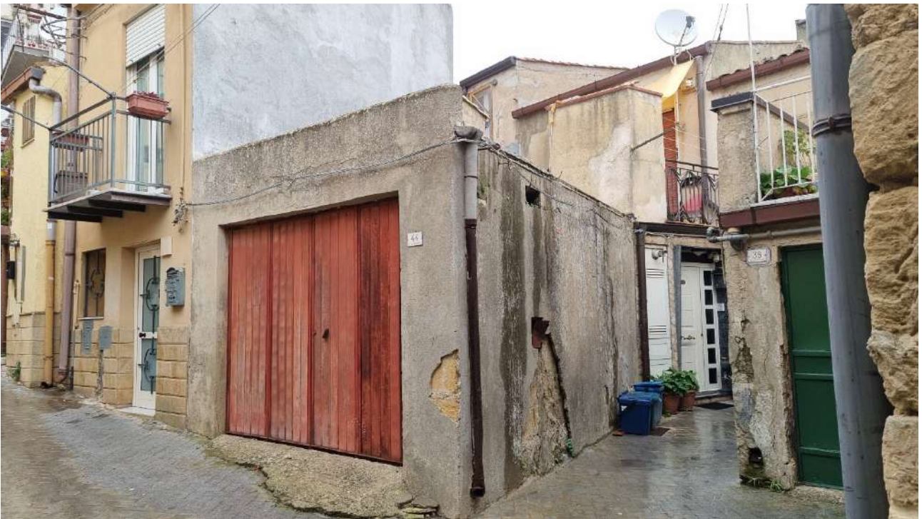
20251118_111905– Esterno – Via San Sebastiano
