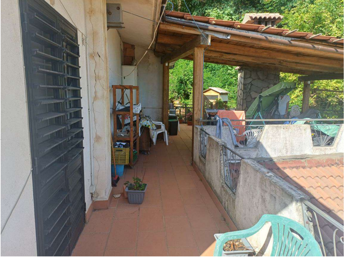
Foto N.3: Prospetto fabbricato angolo Nord.
