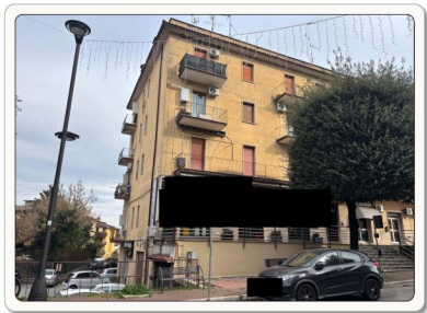
Vista esterna della facciata Nord-Est dell'edificio
