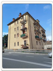
Vista esterna della facciata laterale Sud-Est e Sud-Ovest dell'edificio
