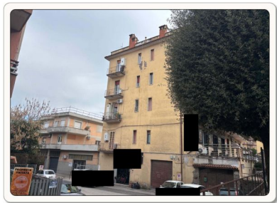
Vista esterna della facciata laterale Nord-Est dell'edificio
