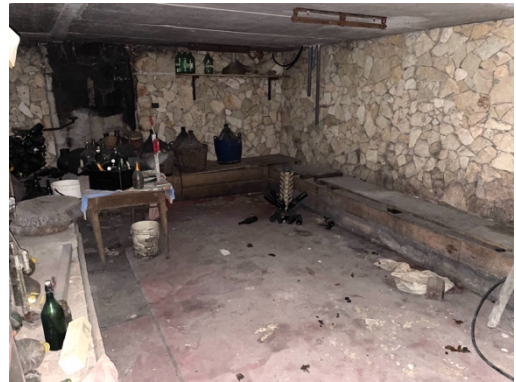
Figura 19. Foto immobile – Piano interrato
