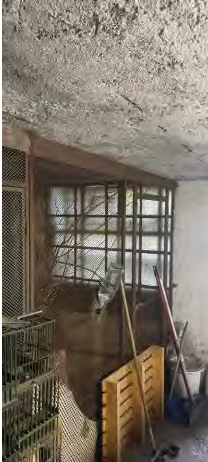
03 – Interno del garage
