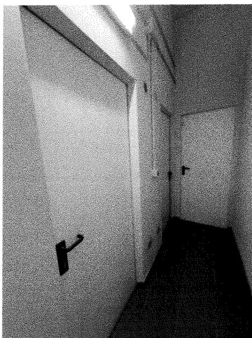
Foto 1. Corridoio di accesso
