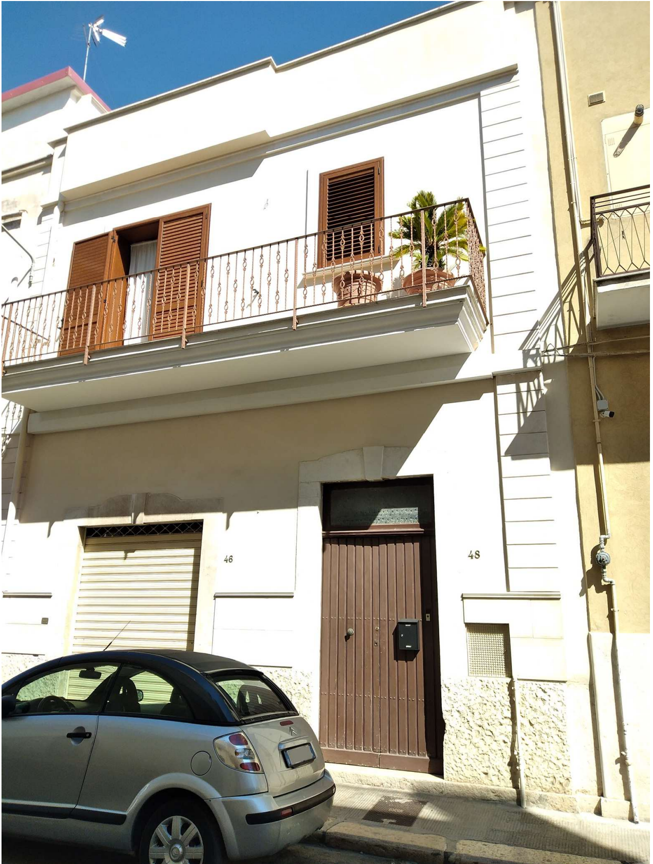
Foto n. 2 : Prospetto esterno dell'immobile
