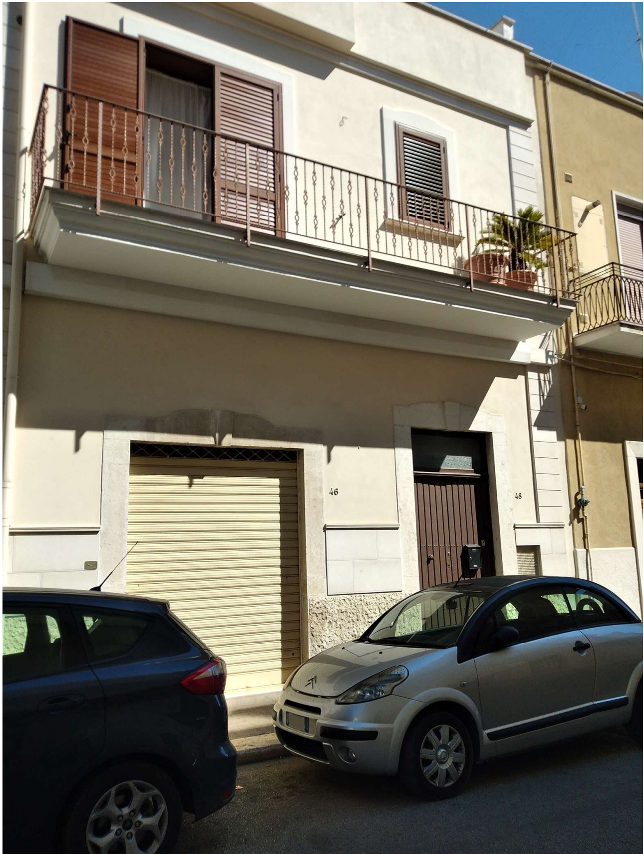
Foto n. 1: Prospetto esterno dell'immobile
