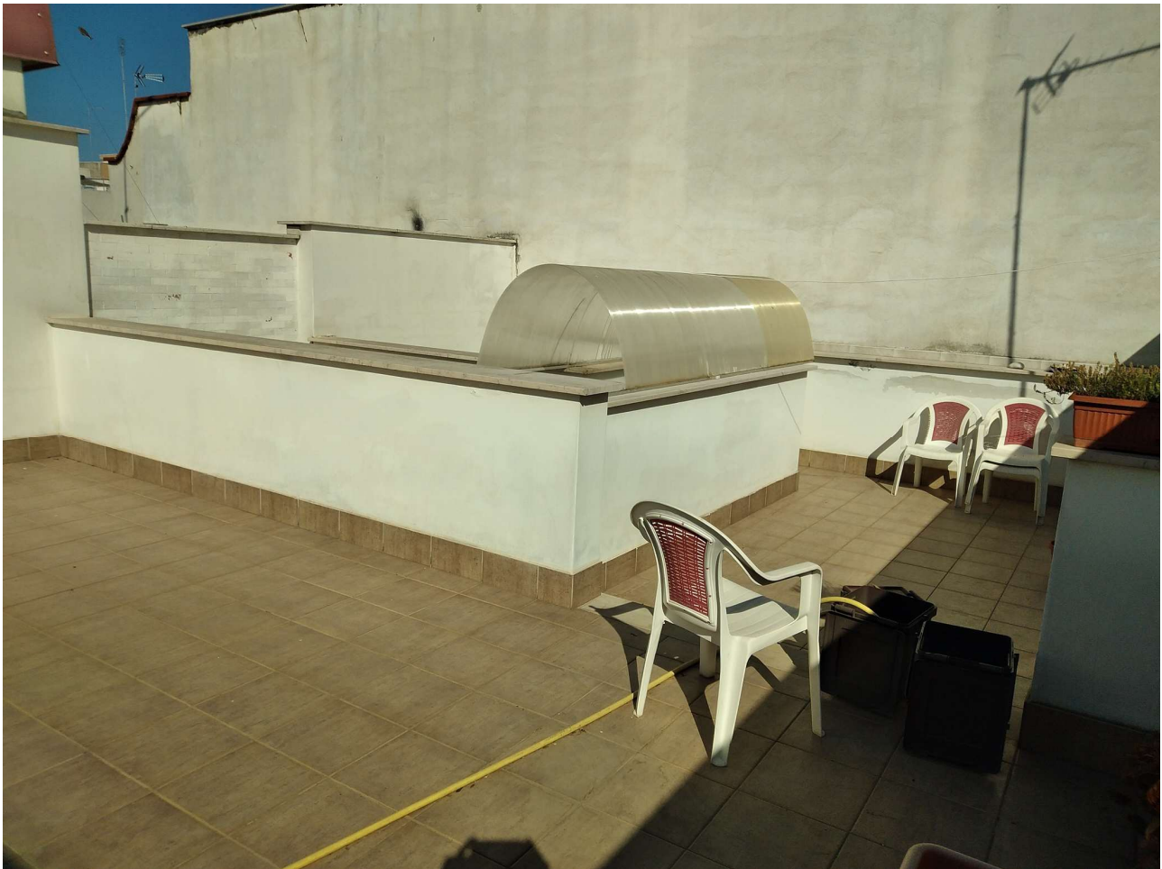
Foto 17: lastrico solare dell'immobile
