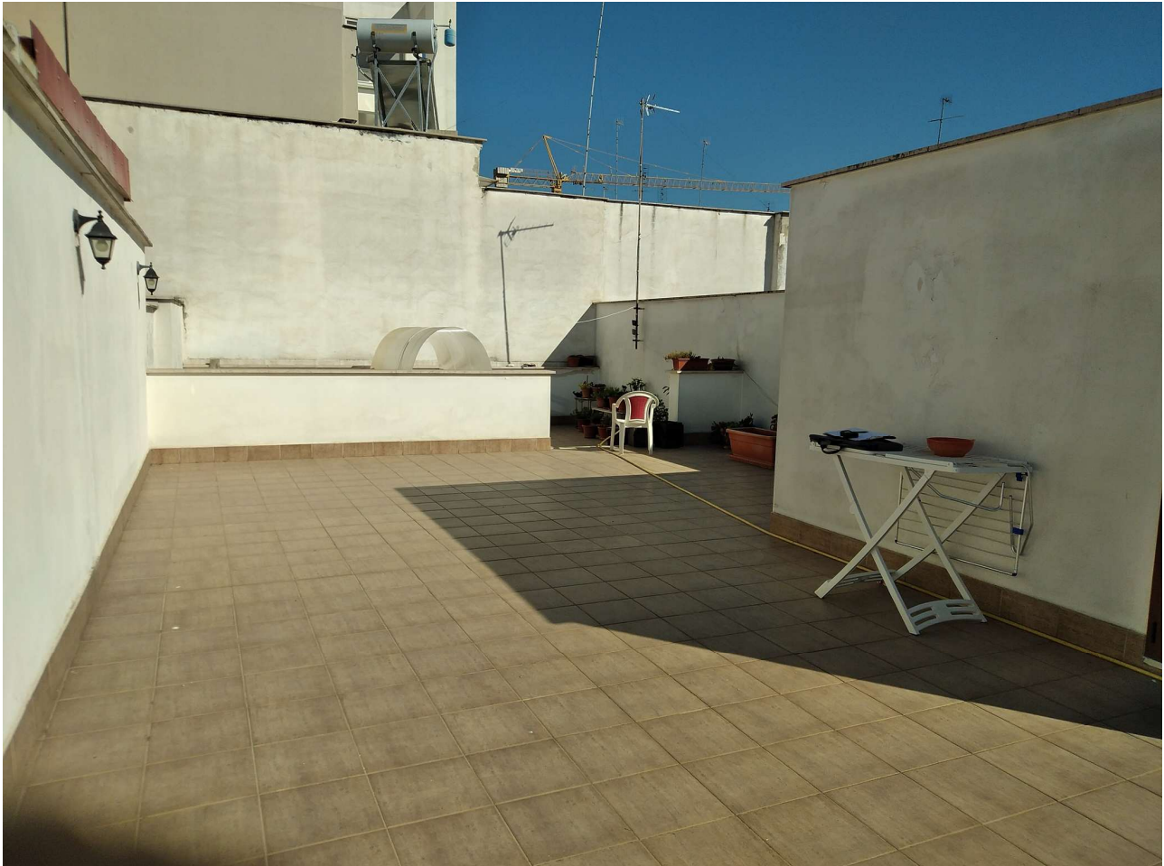
Foto 18: lastrico solare dell'immobile
