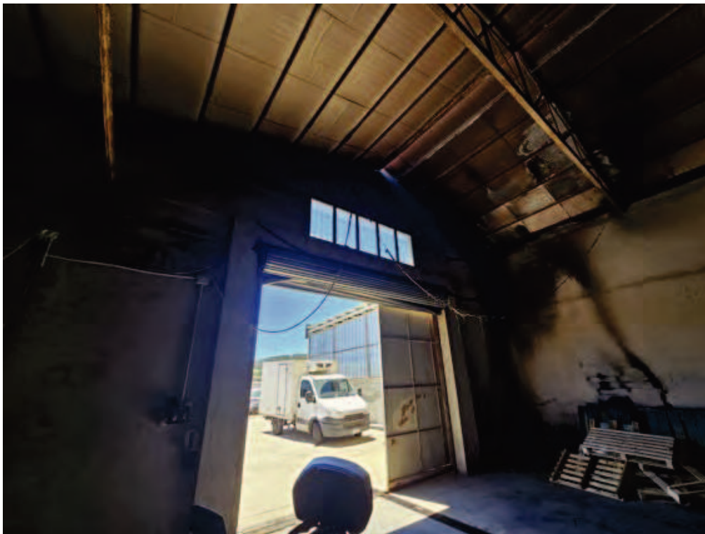
Fotografia E.6 - Magazzino
