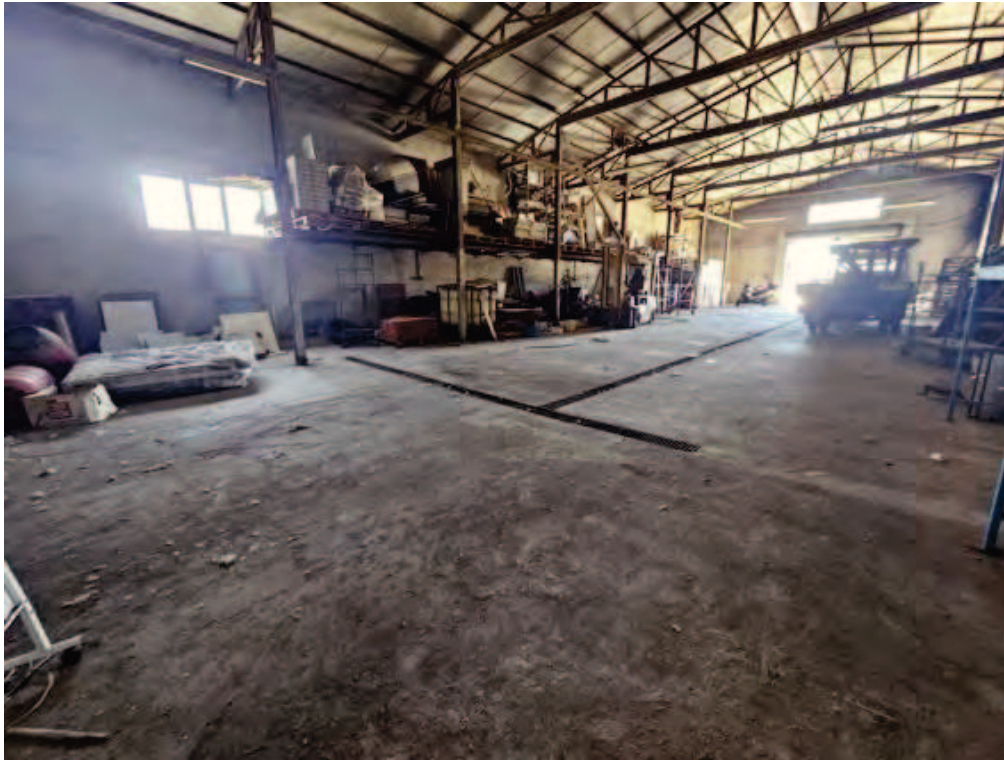
Fotografia E.5 - Magazzino
