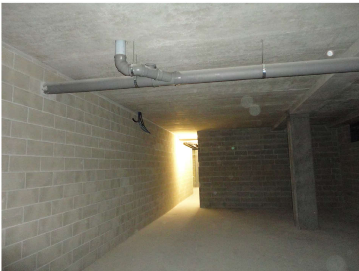
Residenza Belvedere – interno magazzino
