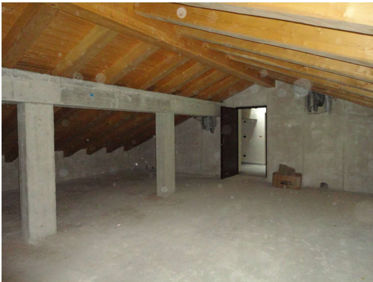
Residenza Argentera – interno sottotetto
