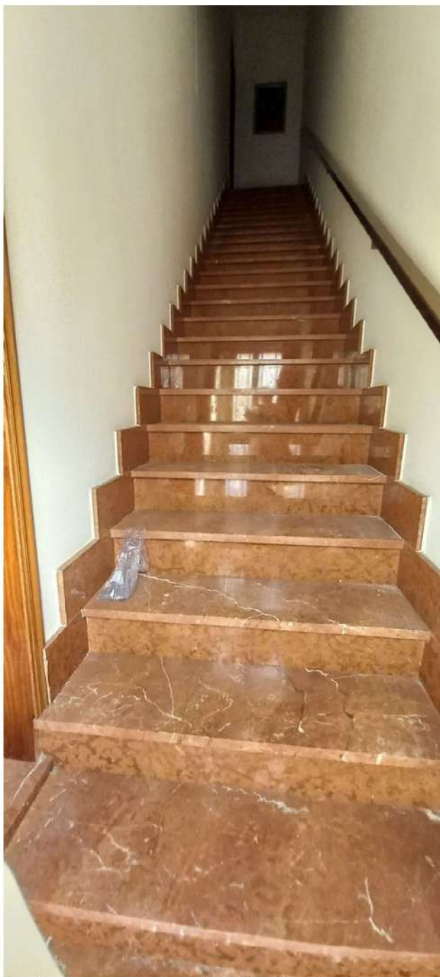
Foto 10: vano scale accesso primo piano abitazione lotto 2
