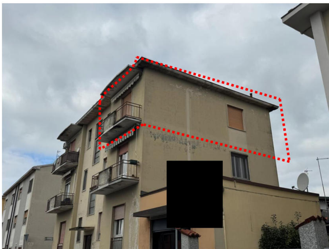
Foto 2. Identificazione dell'appartamento sul prospetto sud-est
