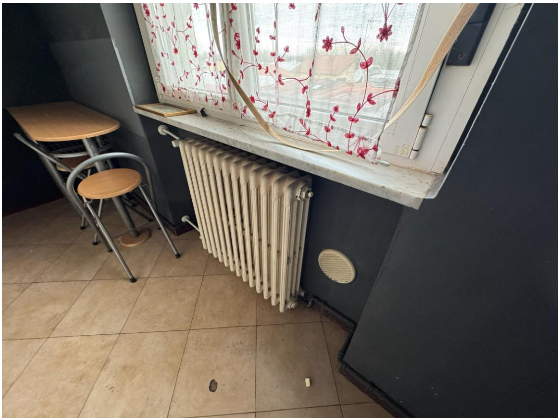
Foto 10. Particolare pavimenti in piastrelle
