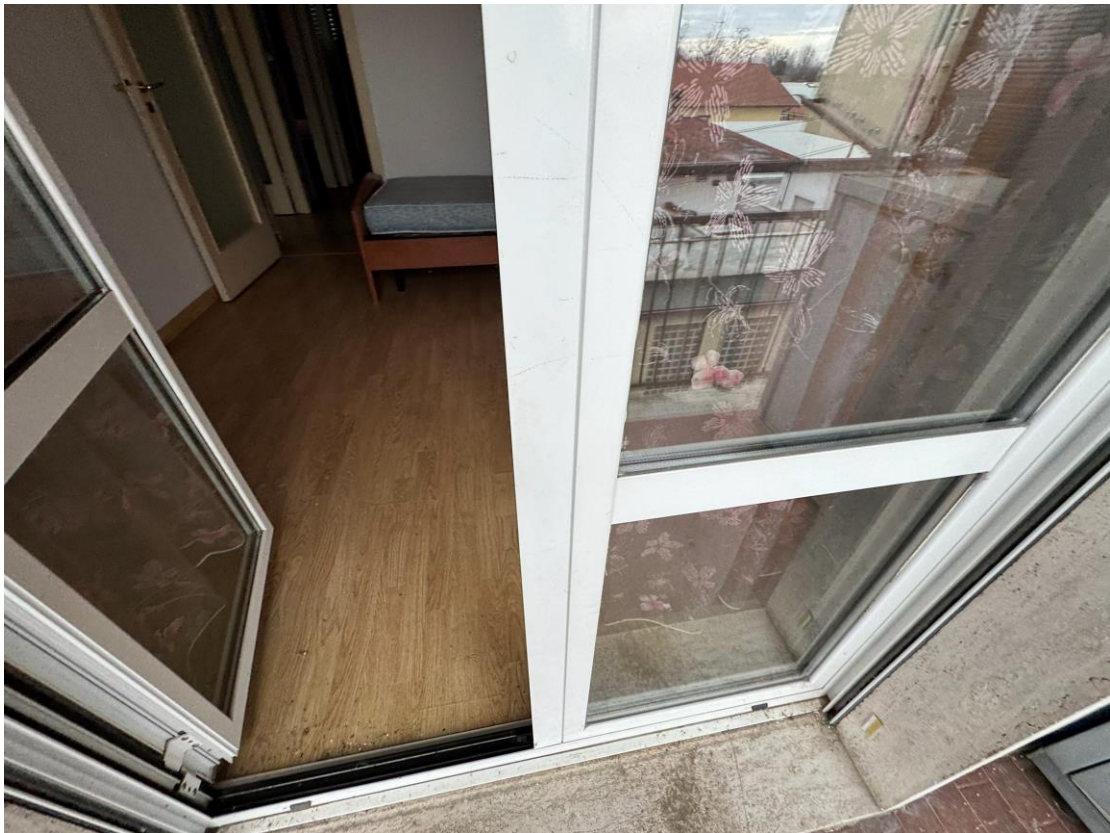
Foto 16. Particolare infissi esterni
