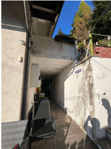
Passaggio PM1 verso il giardino a nord
