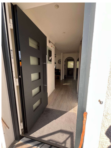
Porta esterna d'accesso PM1 al 1 piano
