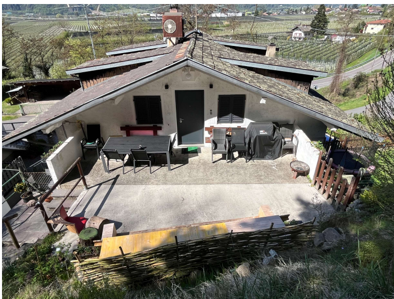
Terrazza PM1 adiacente al balcone PM2
