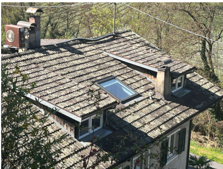
Tetto nel lato a nord
