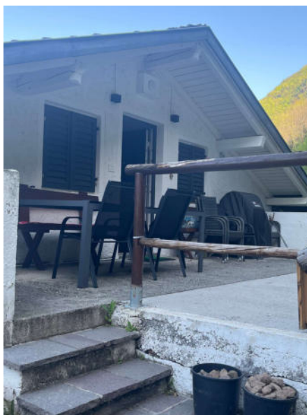
Gradini lato est della PM2 e terrazzino
