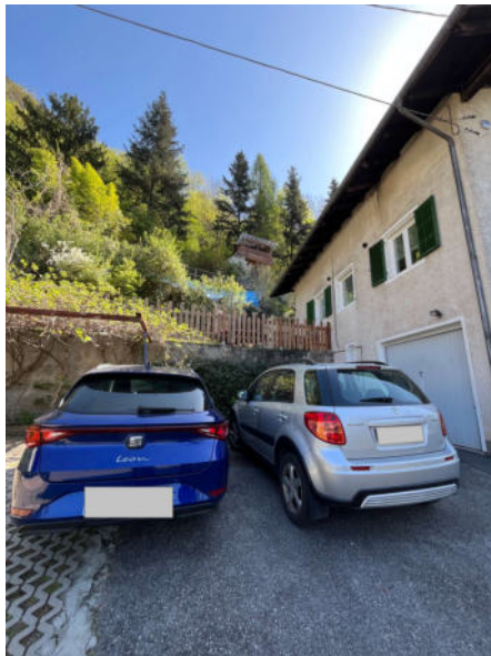
Facciata a nord dalla strada
