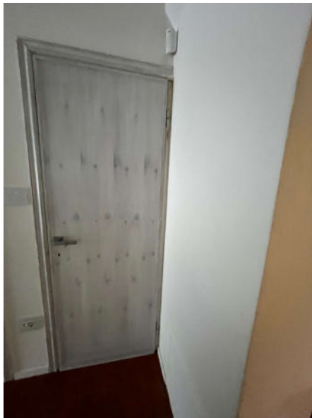
Porta di accesso rampa scala PM2
