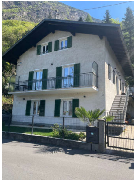
Fronte principale su strada ad ovest
