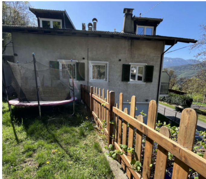
Facciata a nord con il terrapieno PM1
