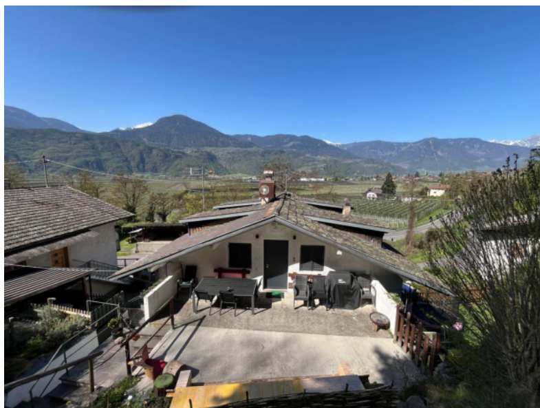
Facciata ad est con ingresso PM2
