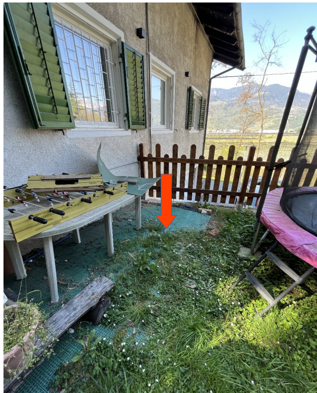
Prato sopra la cisterna adiacente alla casa
