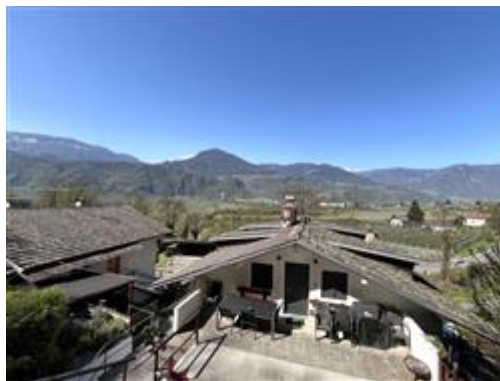
Facciata ad ovest con ingresso appartamento e vista panoramica
