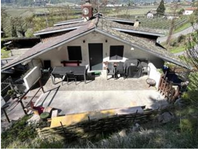
Vista del prospetto ad est con ingresso appartamento
