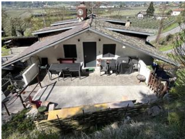
Vista della terrazza in cemento al P2 dal boschetto superiore
