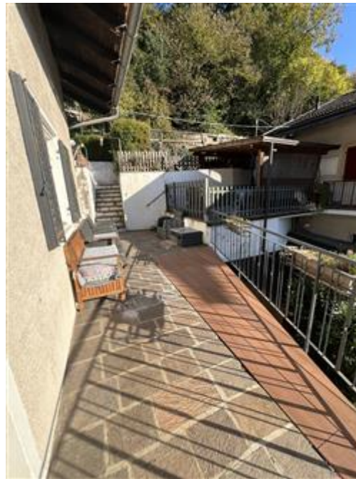
Vista del ballatoio d'ingresso al P1
