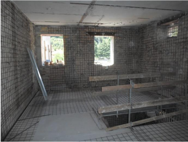
Foto 13 – Interno Via Regina Margherita p. 1
