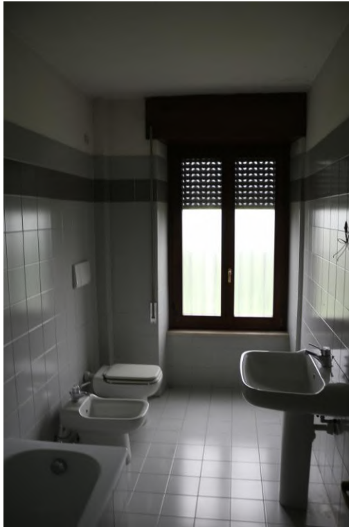
FOTO N°13. - visione interna - APPARTAMENTO SUB. 7 - LOTTO 3
