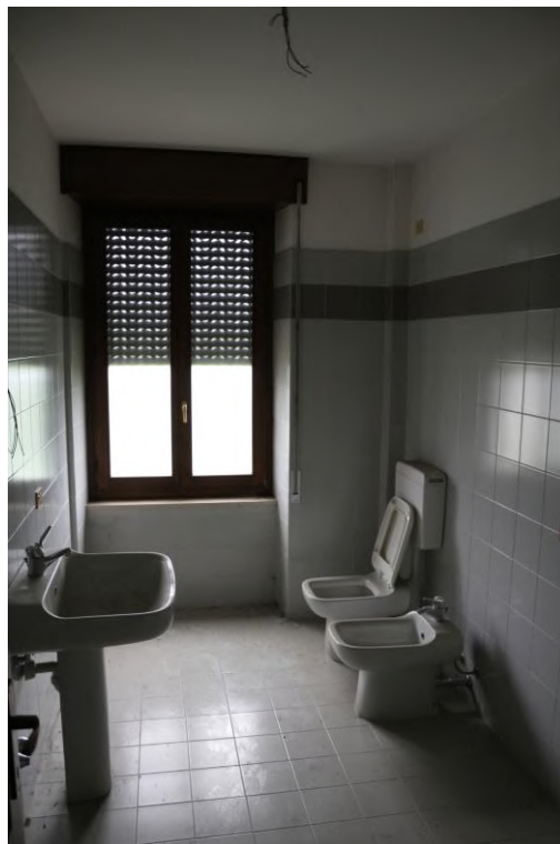
FOTO N°8. - visione interna - APPARTAMENTO SUB. 5 - LOTTO 1
