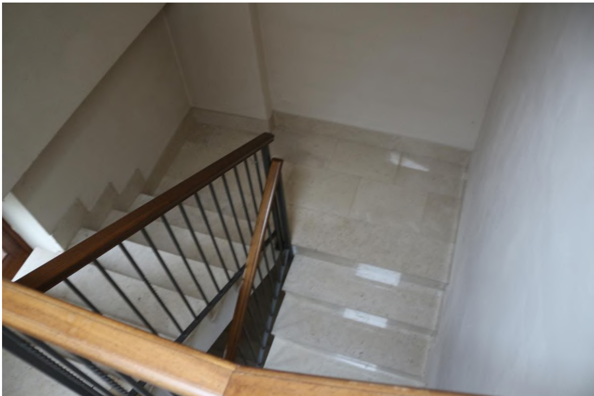
FOTO N°26. - visione interna - AREA VANO SCALE SUBB. 6-8
