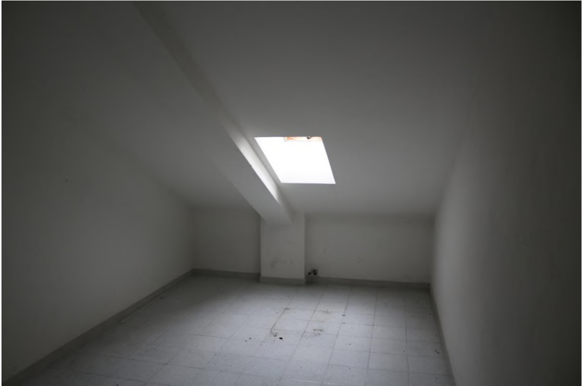
FOTO N°17. - visione interna - AREA SOTTOTETTO SUBB. 5-7
