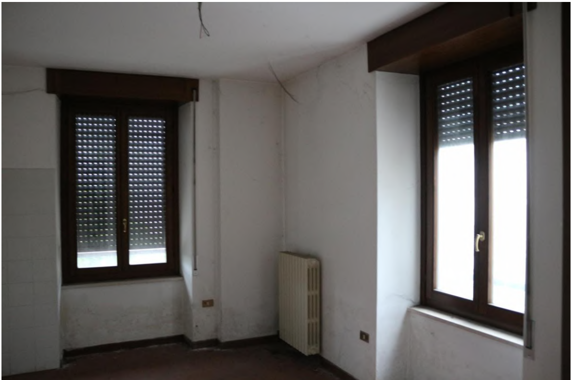
FOTO N°6. - visione interna - APPARTAMENTO SUB. 5 - LOTTO 1
