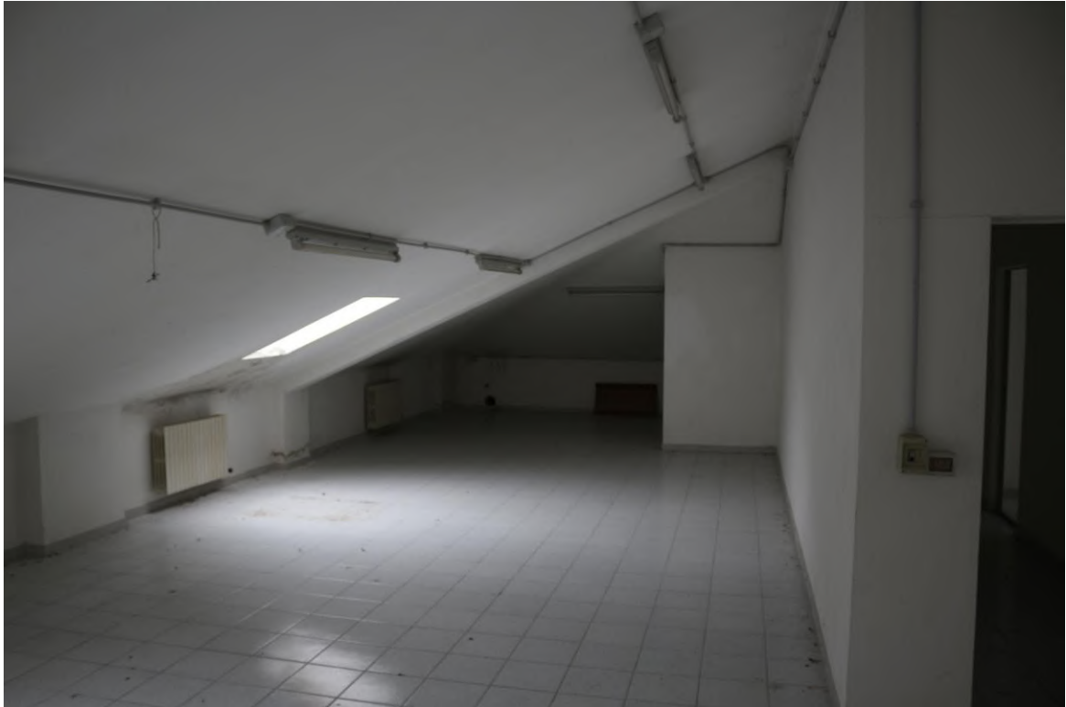
FOTO N°15. - visione interna - AREA SOTTOTETTO SUBB. 5-7
