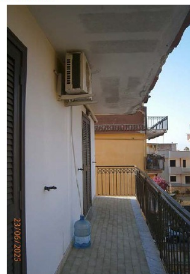
Foto n° 36 Balcone Lato Est
