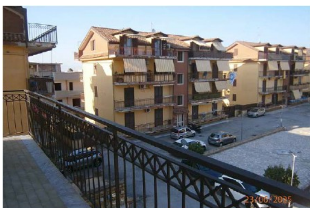
Foto n° 44 Vista Area Condominiale
