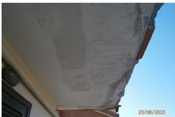
Foto n° 40 Particolare Mensola Lato Est
