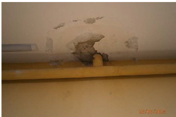
Foto n° 31 Particolare Soffitto Lato Ovest
