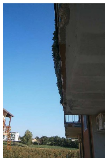
Foto n° 41 Particolare Mensola Lato Est
