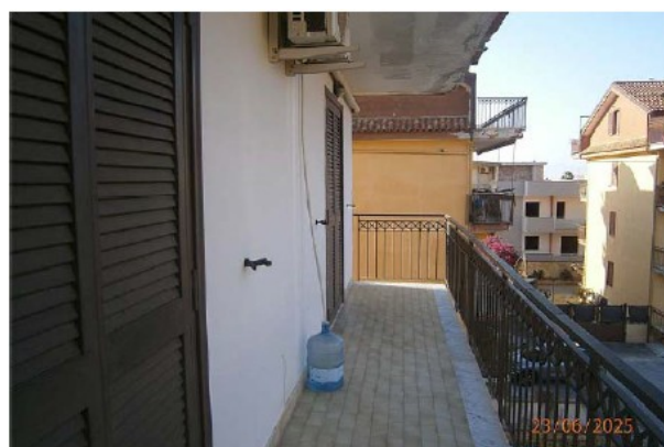
Foto n° 35 Balcone Lato Est
