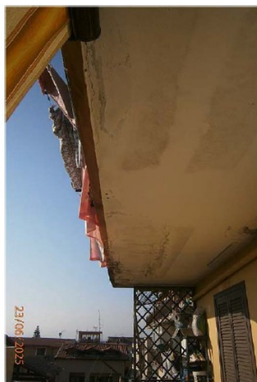
Foto n° 34 Particolare Soffitto Lato Ovest
