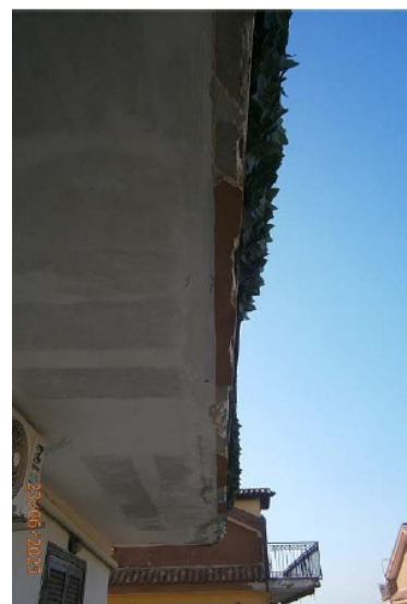
Foto n° 39 Particolare Mensola Lato Est
