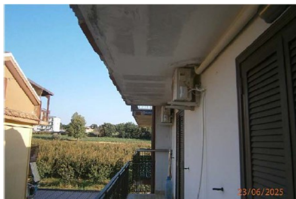
Foto n° 37 Balcone Lato Est
