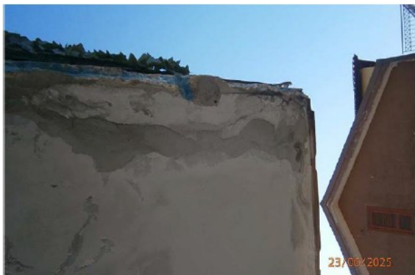
Foto n° 38 Particolare Mensola Lato Est
