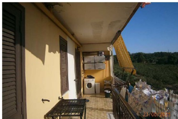
Foto n° 32 Balcone Lato Ovest
