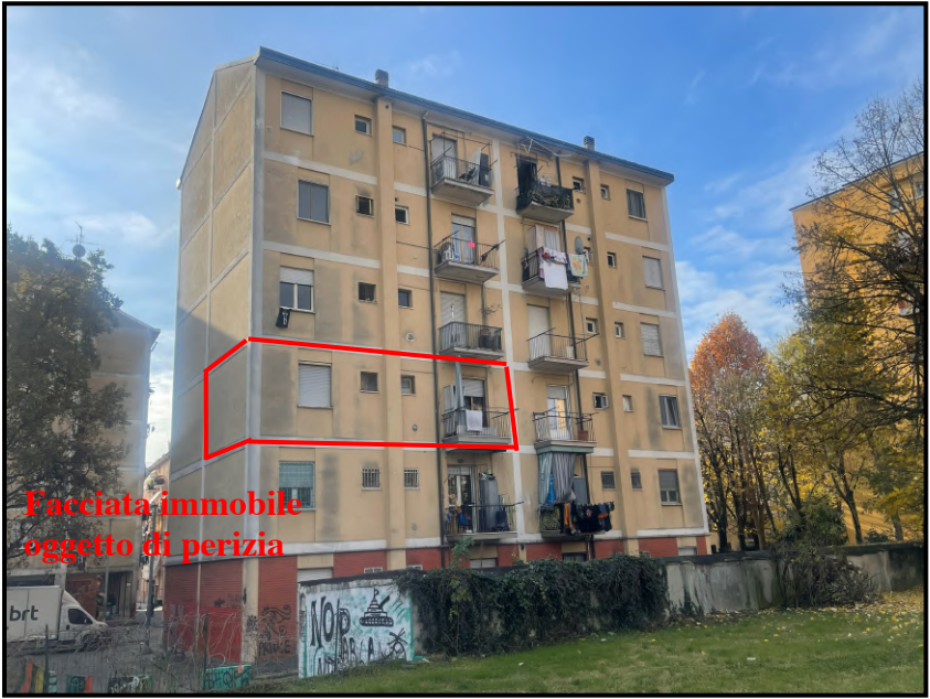
Vista facciata NORD
