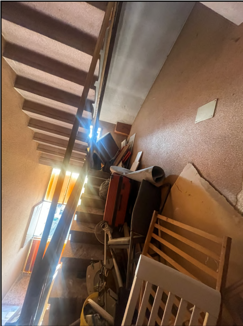
Vano scale ostruito per accedere al solaio
