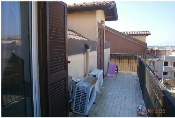
Foto n° 66 Balcone Lato Est
