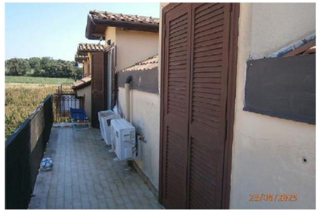
Foto n° 67 Balcone Lato Est
