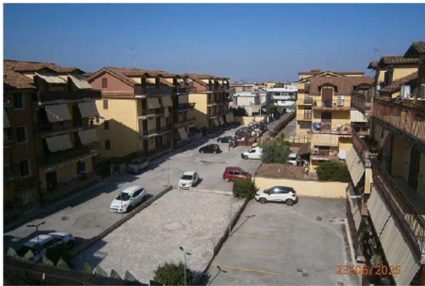
Foto n° 73 Vista Area Condominiale
