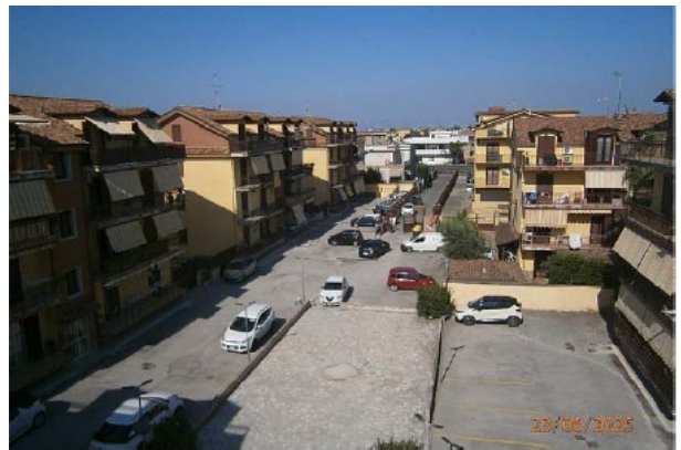
Foto n° 74 Vista Area Condominiale
