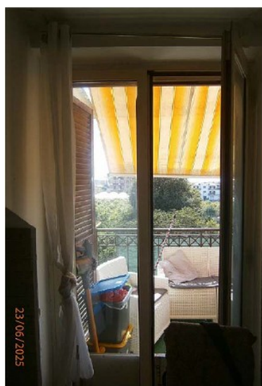
Foto n° 65 Particolare Infisso Esterno
