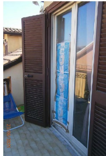
Foto n° 64 Particolare Infisso Esterno
