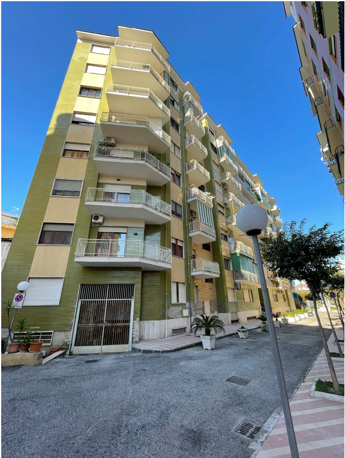
Fabbricato Ovest. Prospetto sul viale privato
