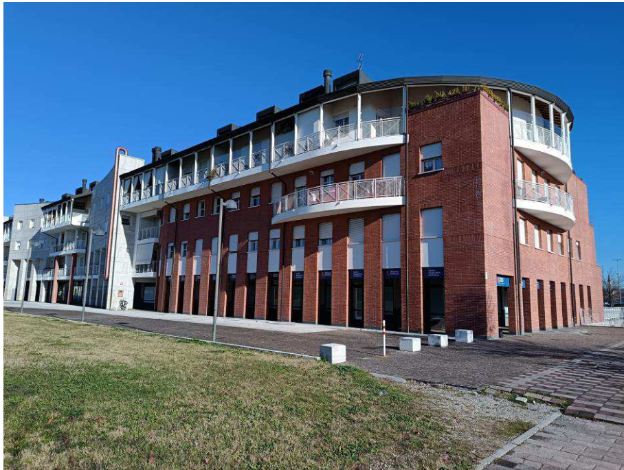
Condominio "Le Logge" scala F, lato sud-ovest
