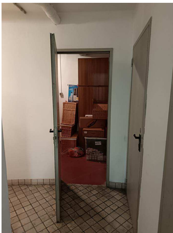
Cantina, piano interrato, porta d'ingresso, M.N. 1029 sub 787
