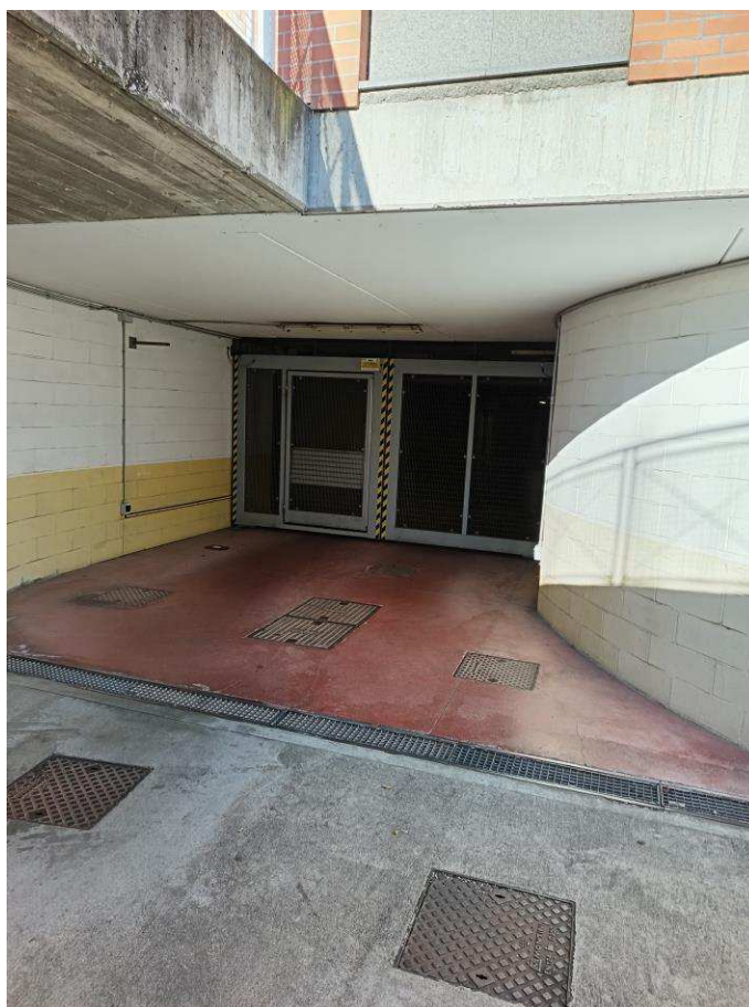
Rampa di accesso al piano interrato del condominio, lato sud
