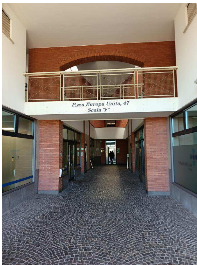
Portico al p.terra (sub 2) che porta alla scala d'ingresso del Condominio
