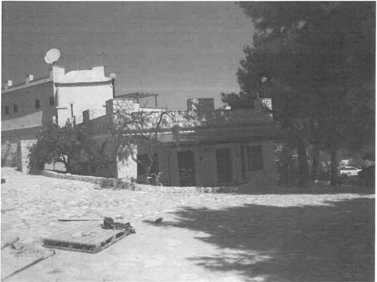
13 – Esterno: inquadratura dal lato dell'ingresso secondario.
