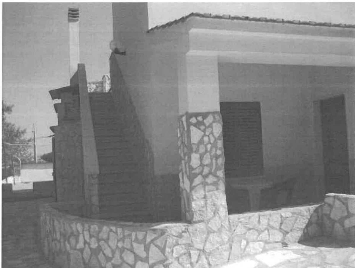
19 – Esterno: portico di accesso al primo piano e scalinata verso il secondo piano.
