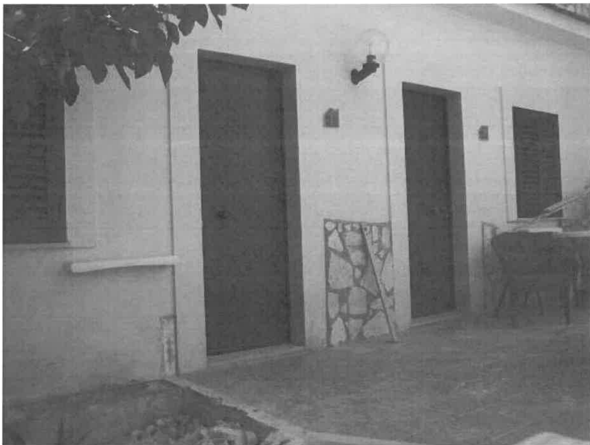
29 – Esterno: fabbricato ad un piano.
