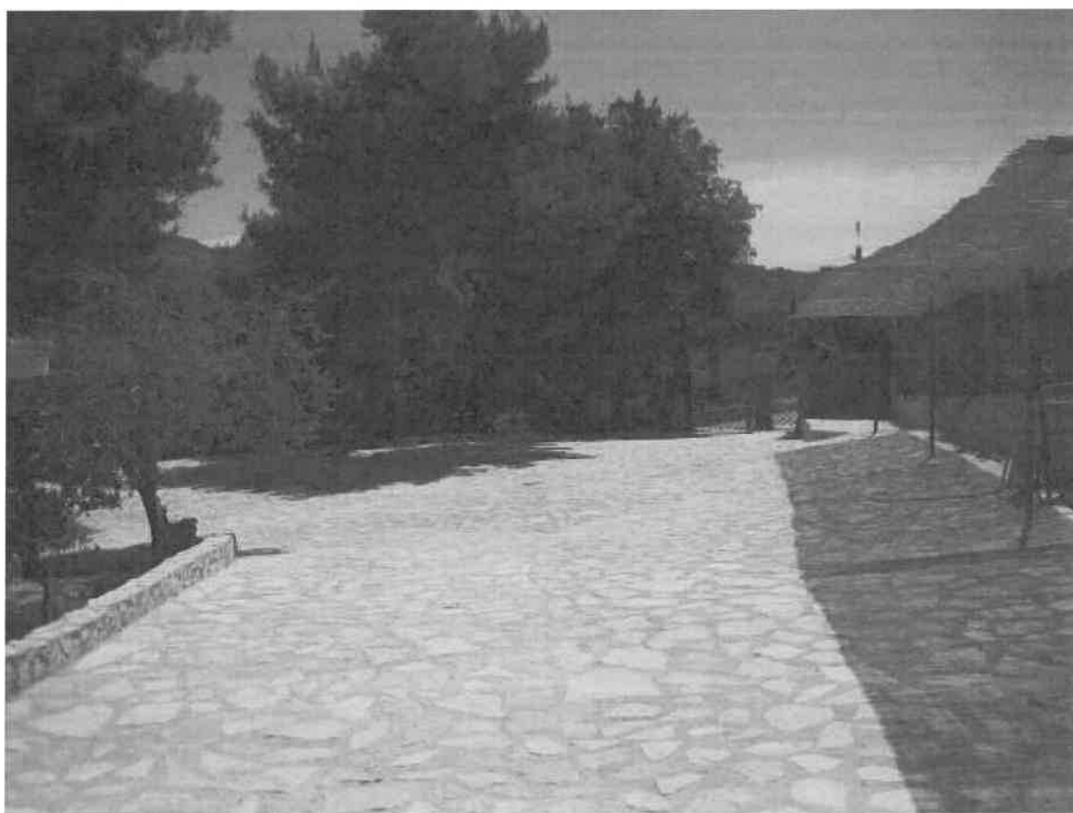
30 – Esterno: lastricato in direzione ingresso secondario.
