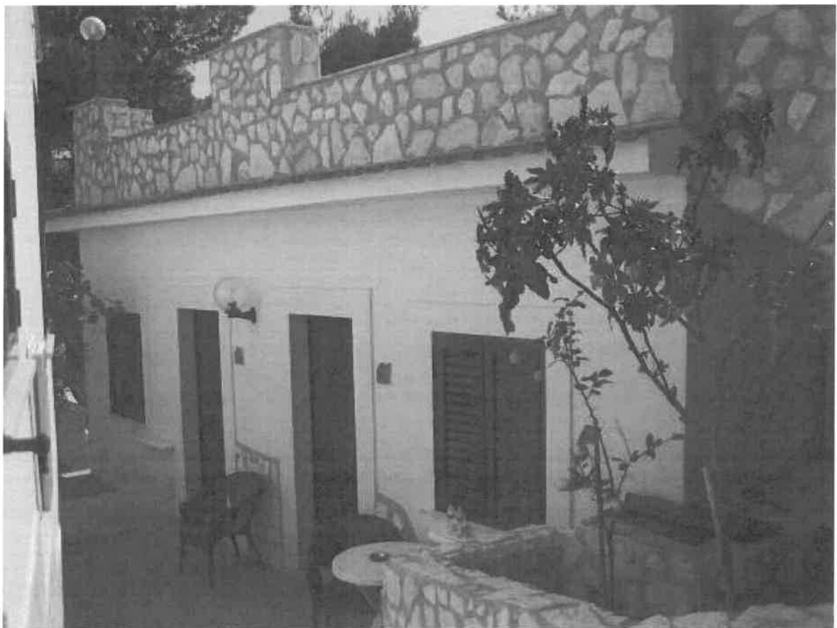
28 – Esterno: fabbricato ad un piano.
