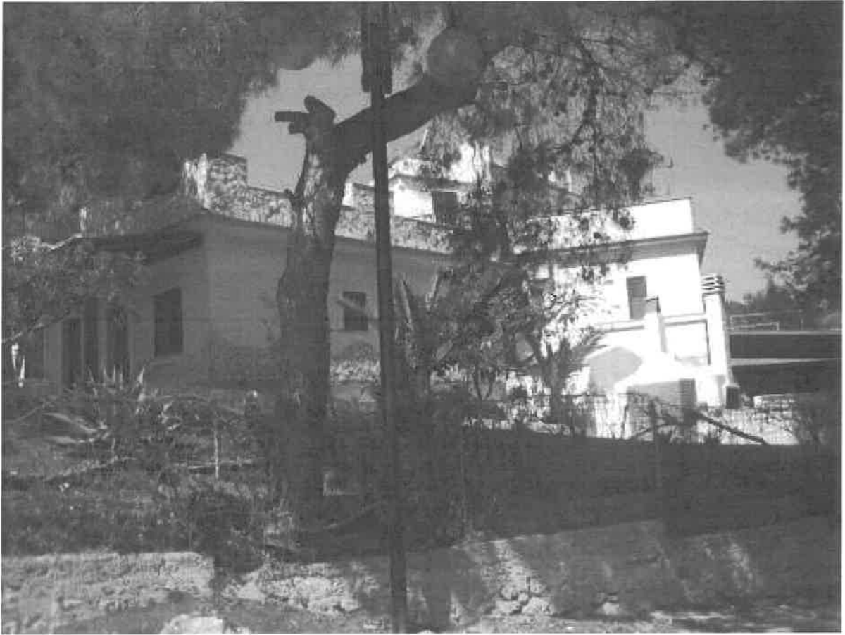
5 – Esterno: tettoia del plesso principale..
