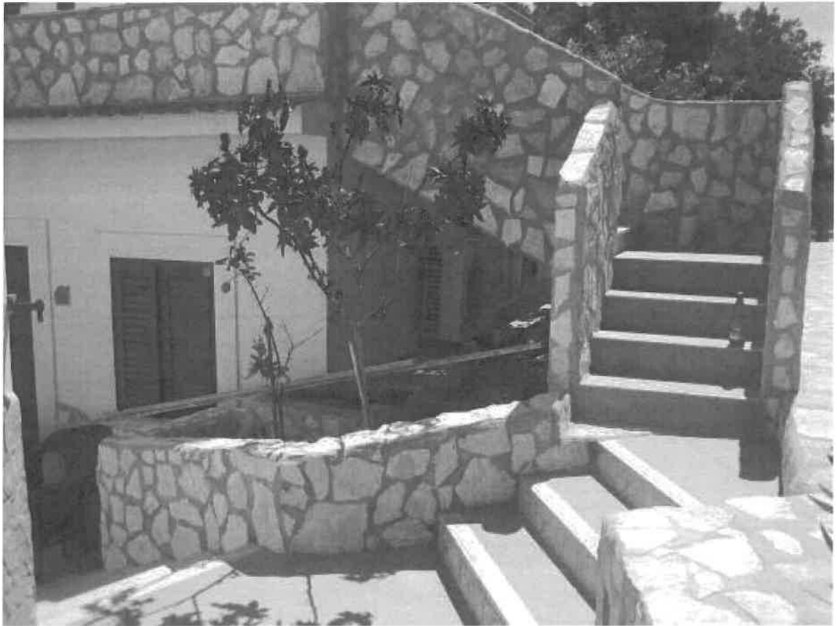
27 – Esterno: fabbricato ad un piano e scalinata sul terrazzo sovrastante.
