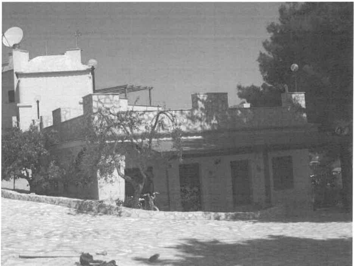
14 – Esterno: inquadratura dal lato dell'ingresso secondario.
