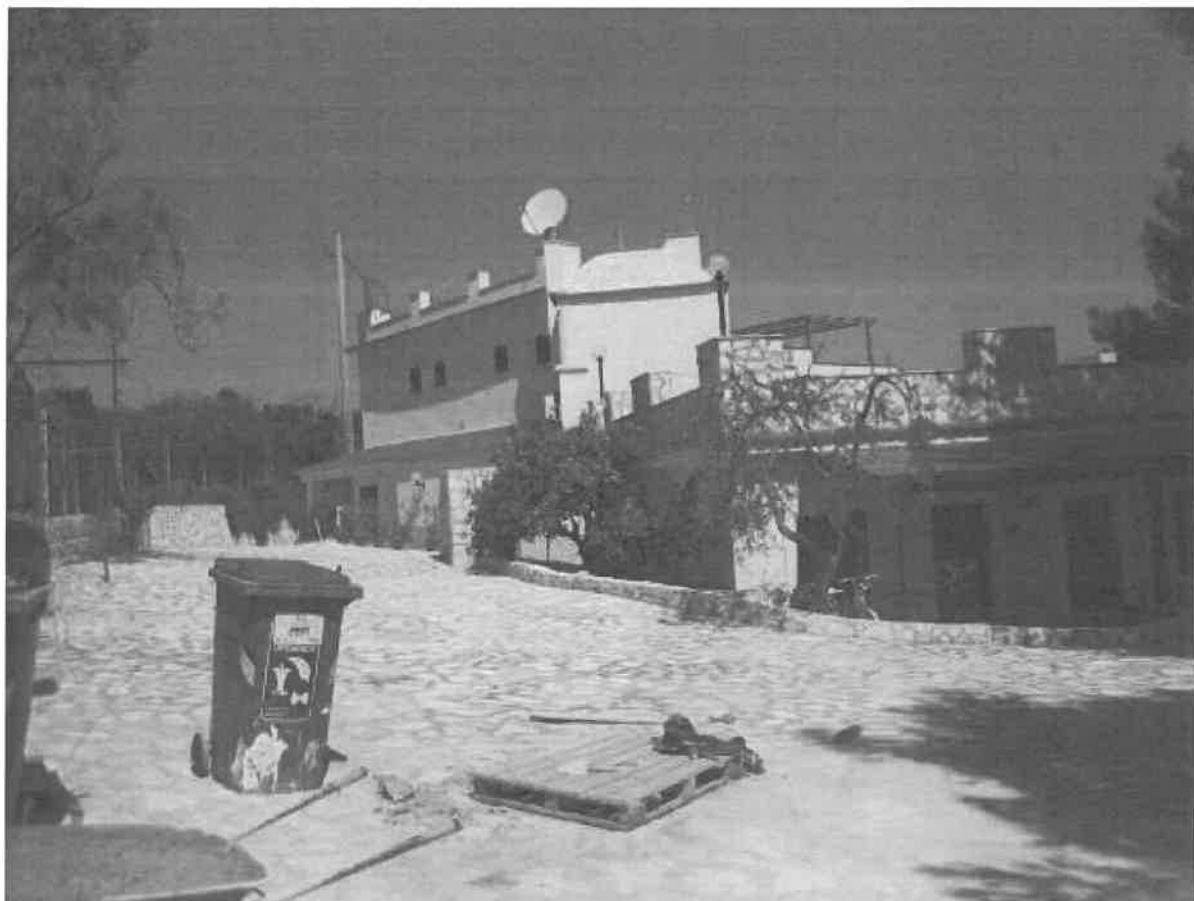
15 – Esterno: inquadratura dal lato dell'ingresso secondario.
