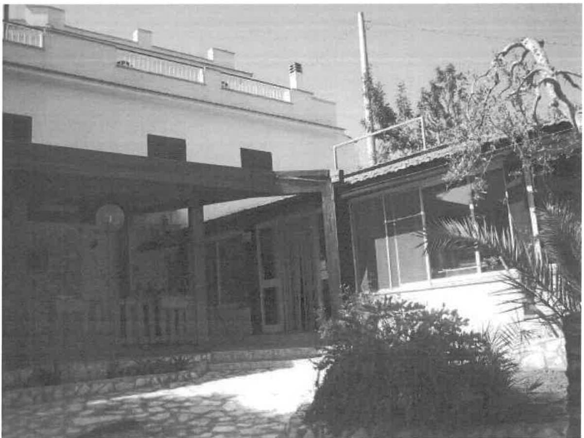
4 – Esterno: tettoia e veranda.
