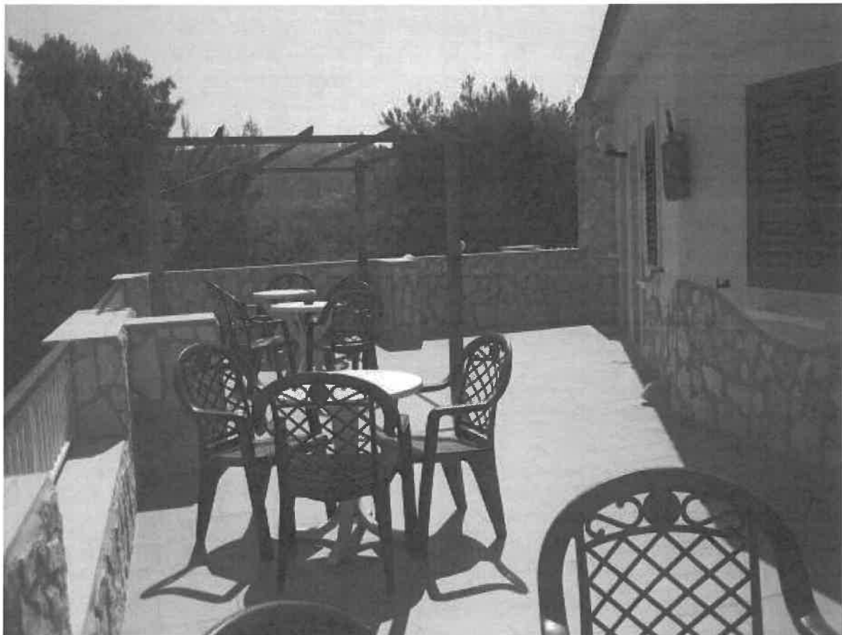
25 – Esterno P.2°, facciata porte di accesso alle quattro camere dal terrazzo comune.
