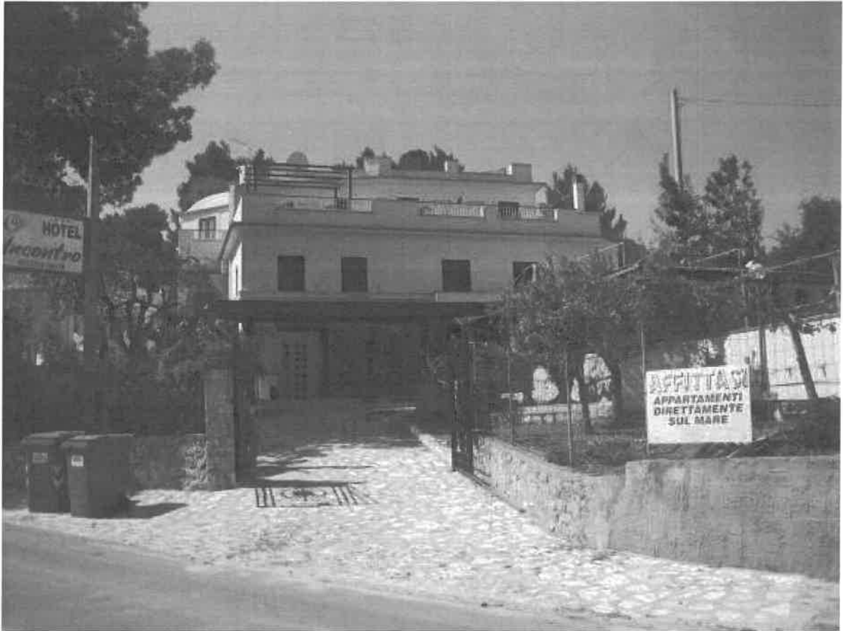
1 – Esterno: ingresso principale dalla S.S. km 83+000.
