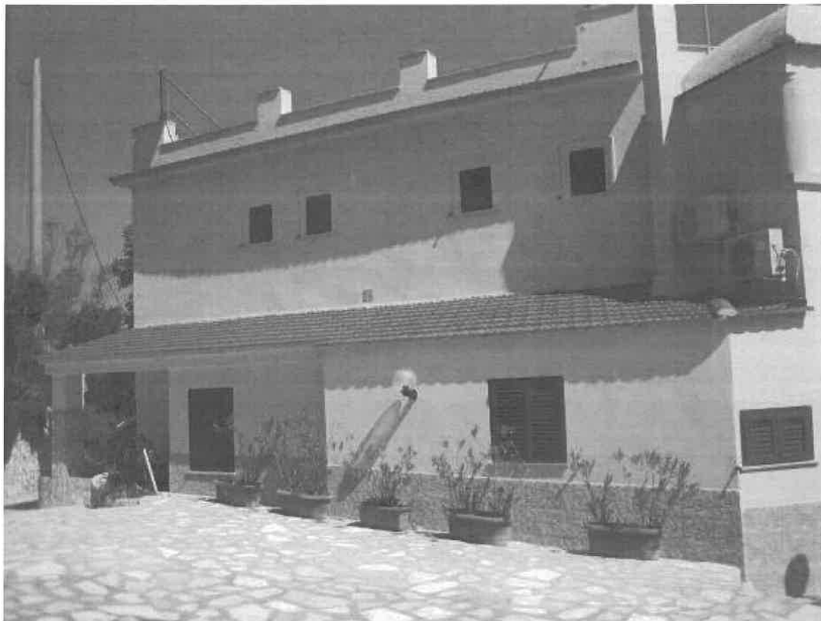
17 – Esterno: facciata posteriore (primo e secondo piano).
