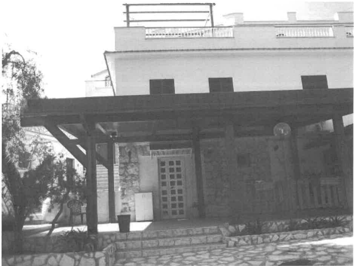
3 – Esterno: tettoia del plesso principale.
